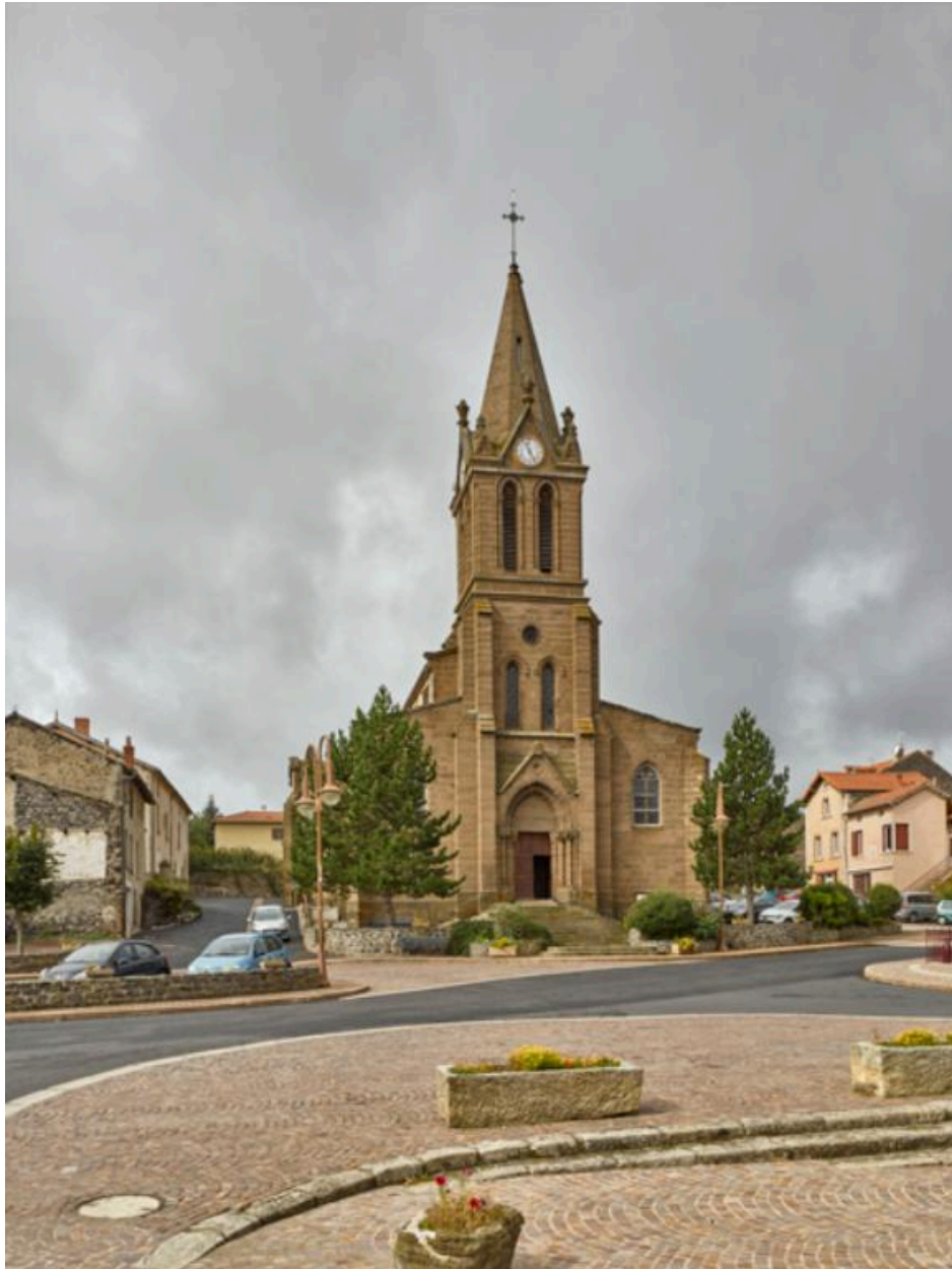
Vue de la façade occidentale
