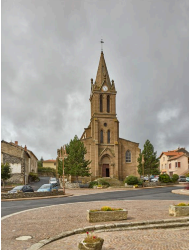
Vue de la façade occidentale
