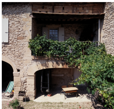
Détail d'une partie du logis et du pigeonnier. Phot. Alain Franchella IVR82_19992600316XA
