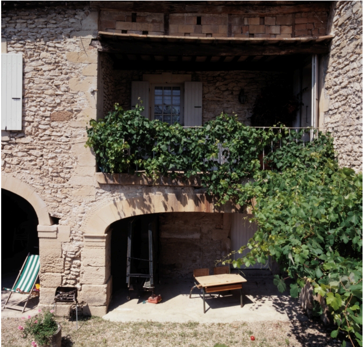
Détail d'une partie du logis et du pigeonnier.
