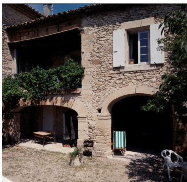
Vue partielle de la ferme depuis la cour. Phot. Alain Franchella IVR82_19992600318XA
