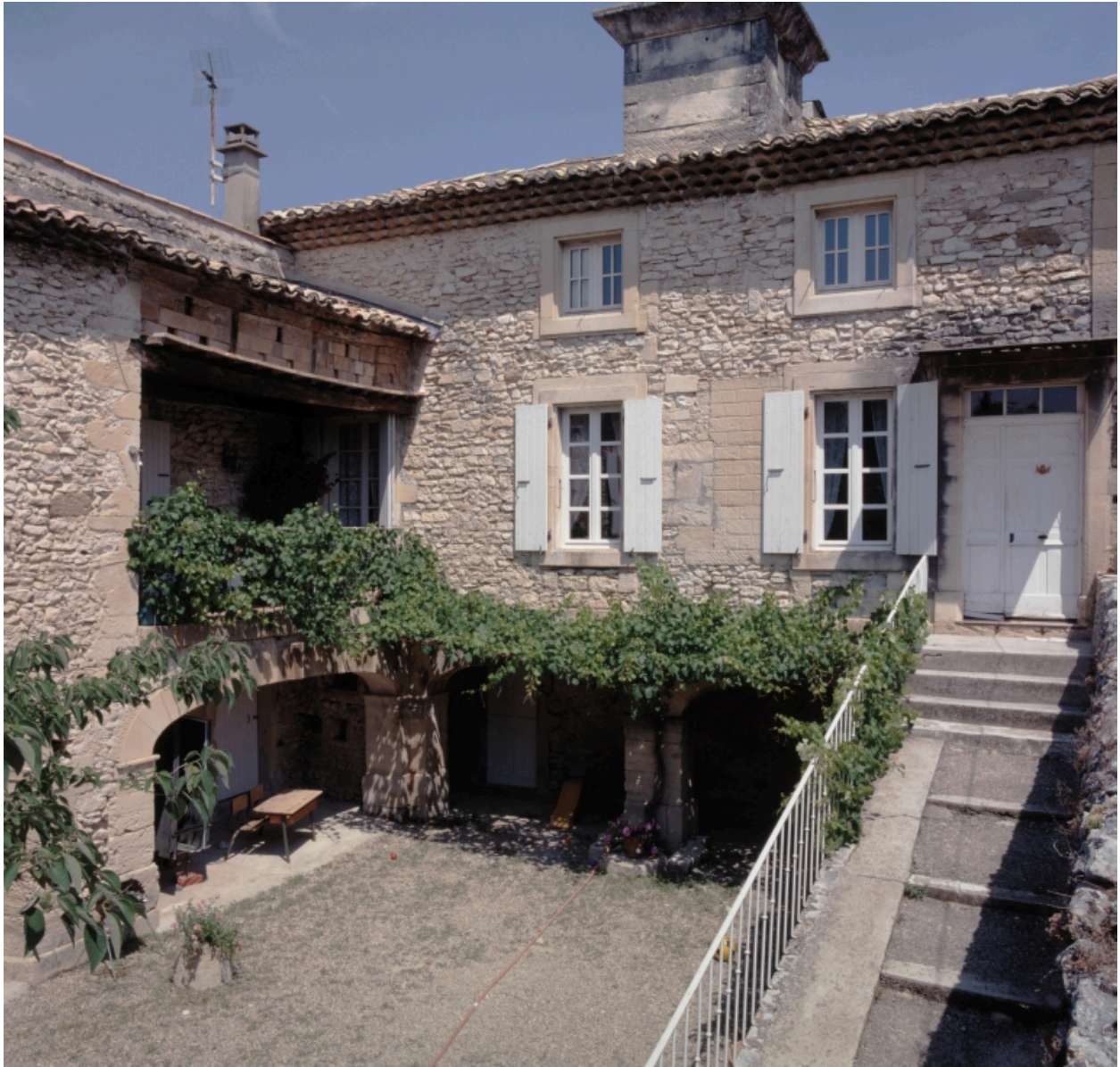
Vue générale de la ferme depuis la cour laissant apparaître la pompe à vent.
