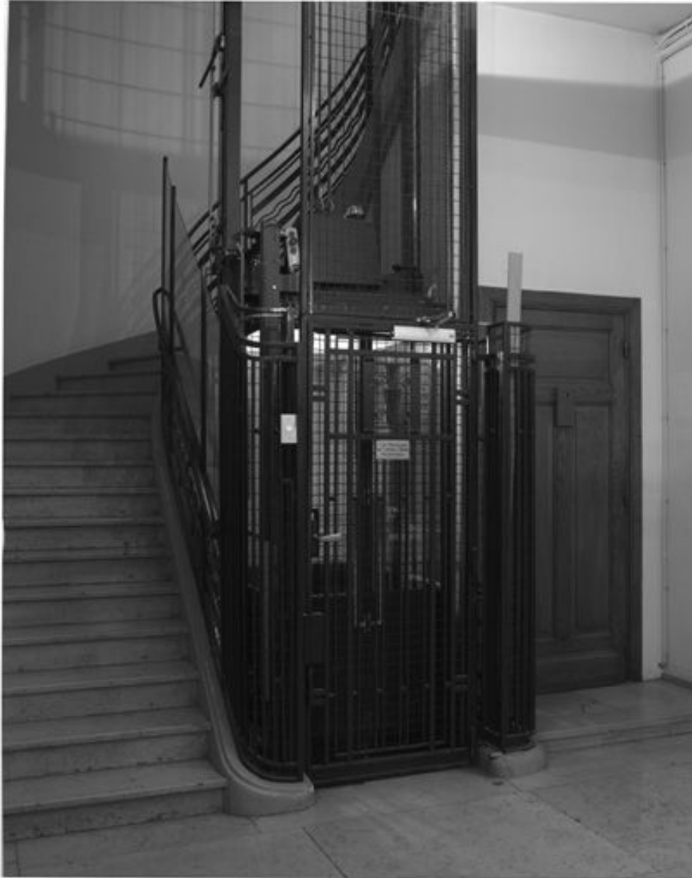
Escalier et ascenseur éclairé vus depuis le palier du rez-de-chaussée
