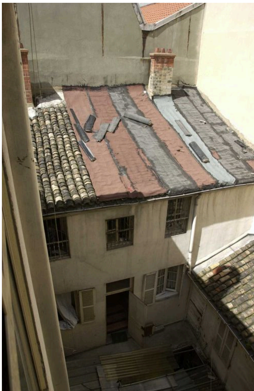
Vue du bâtiment en fond de cour depuis la cage d'escalier de l'immeuble sur rue
