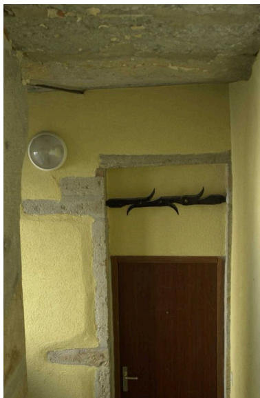
Fermeture de baie en dessus- de-porte murée (étripe-loup) Phot. Véronique Belle IVR82_20026902723NUCA
