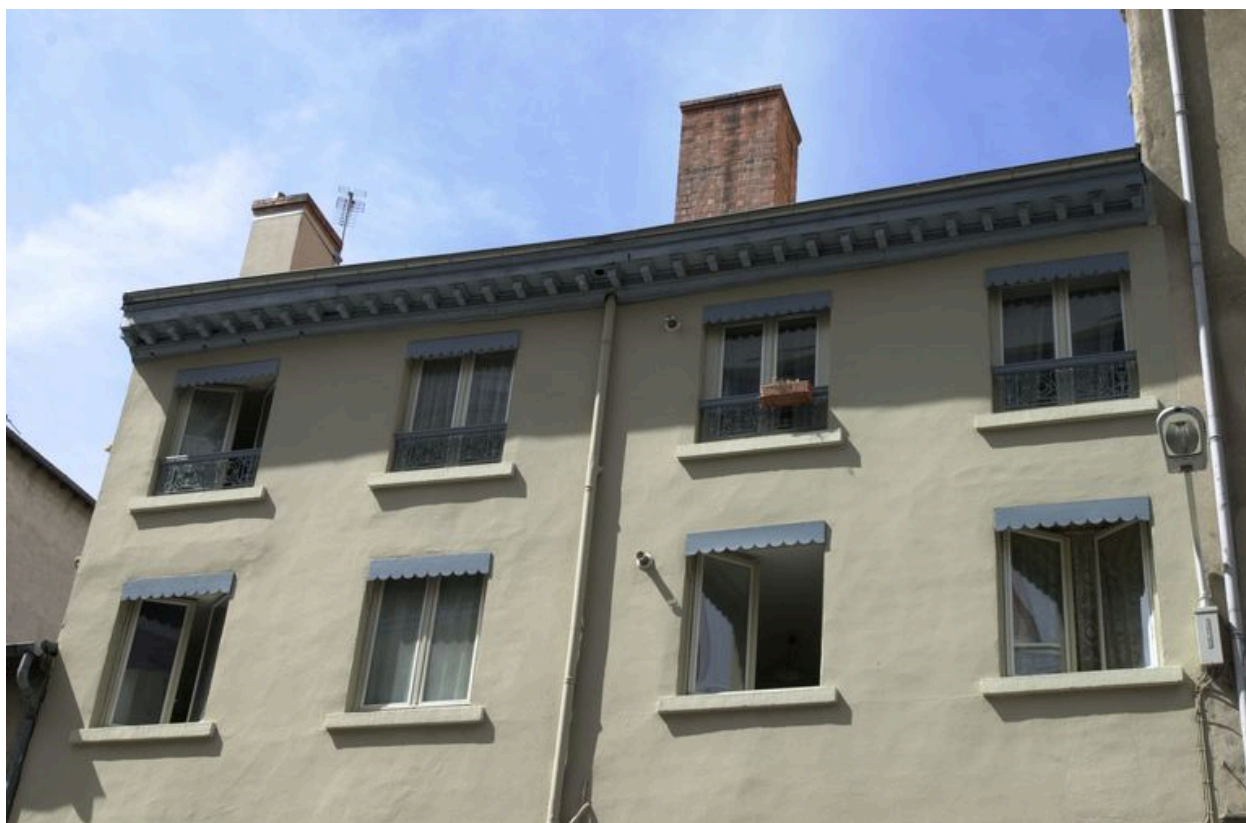
Vue des 2e et 3e étages et de la corniche en bois du toit
