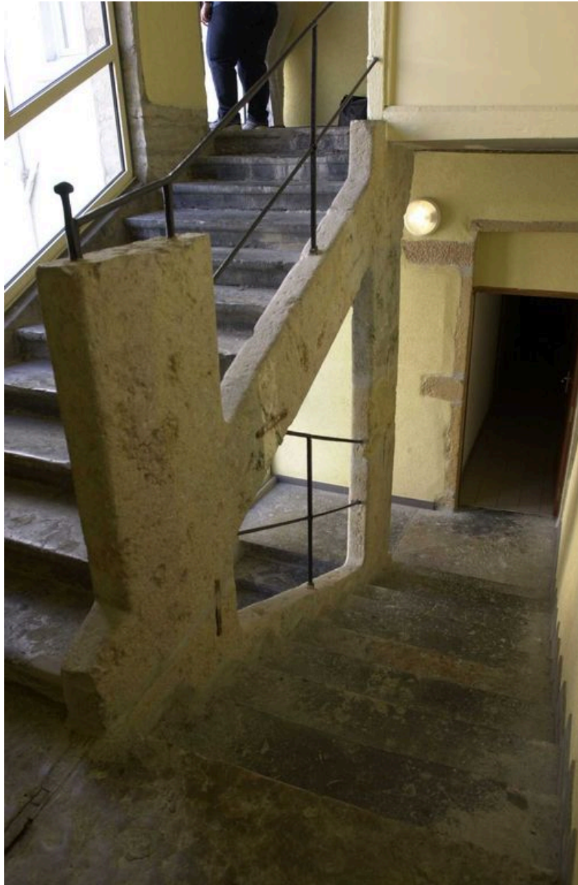
Vue de l'escalier avec mur-noyau ajouré
