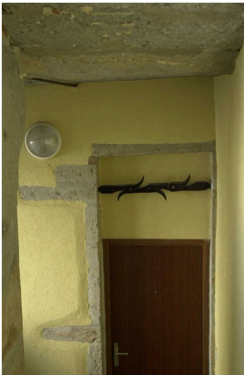
Fermeture de baie en dessus-de-porte murée (étripe-loup)
