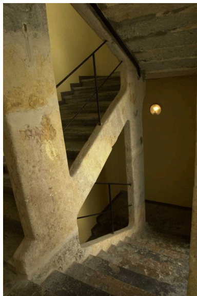
Le mur-noyau ajouré Phot. Véronique Belle IVR82_20026902722NUCA
