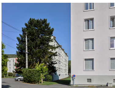
Vue partielle des immeubles collectifs de la cité depuis l'est, sur l'allée de la cité de Grandsaigne. Phot. Christian Parisey IVR84_20206300903NUC4A
