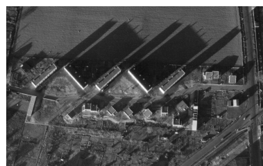
Vue aérienne de la cité, 17/12/1956. Phot. Brigitte Ceroni IVR84_20236300845NUC
