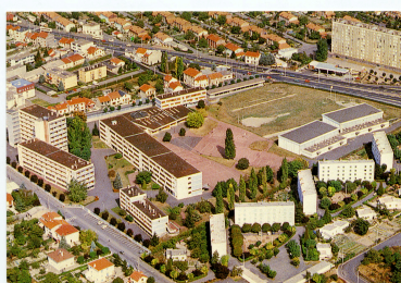
Vue aérienne de la cité (en bas à droite de l'image) : immeubles collectifs implantés en quinconce et maisons individuelles à leur pied. Repro. Christian Parisey, Autr. anonyme IVR84_20206300790NUCA
