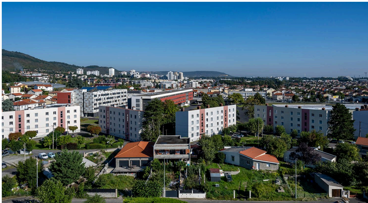
Vue aérienne de la cité ouvrière depuis le sud.
