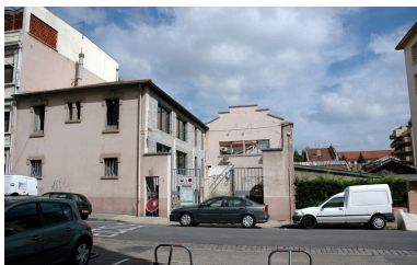
Vue générale Phot. Véronique Belle IVR82_20076902823NUCA
