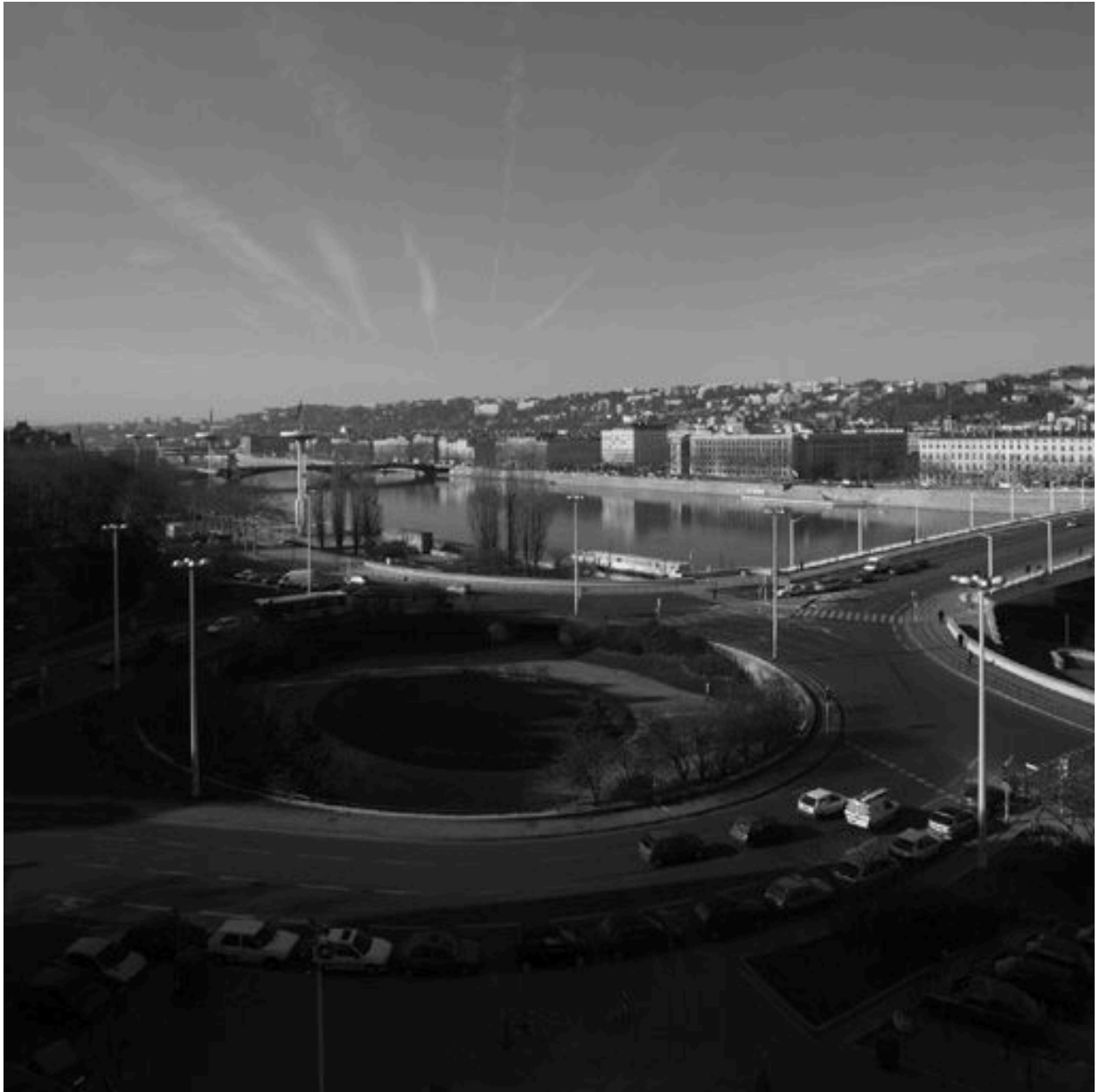
La Fosse aux Ours. Vue générale depuis le Palais de la Mutualité, au nord-est, en 2004
