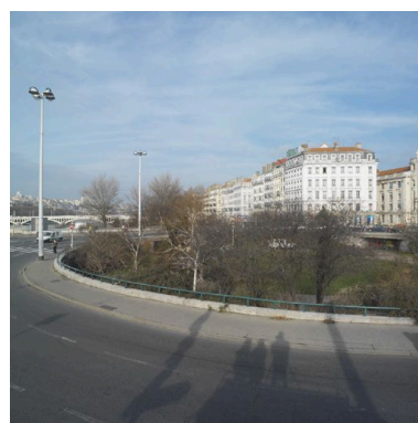
La Fosse aux Ours. Vue d'ensemble depuis le sud, en 2004 Phot. Eric Dessert IVR82_20046904440NUCA
