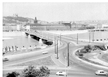
le pont de la Guillotière et le carrefour de la Fosse aux Ours depuis le sud-est / E. Poix ou E. Pernet, photographe, vers 1970 (AC Lyon. 8 PH 1705) Autr. Poix E. (?), Autr. photographe), Autr. Pernet E. (?), Autr. photographe) IVR82_20096901279NUCA
