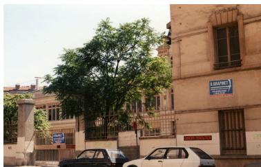
Clôture en alignement sur l'avenue Lacassagne (vers 1995) Phot. Nadine Halitim-Dubois IVR82_20086901825NUCA
