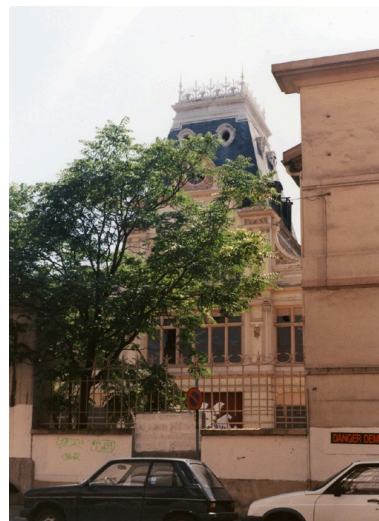
Vue nord (vers 1995 avant démolition) Phot. Nadine Halitim-Dubois IVR82_20086901826NUCA
