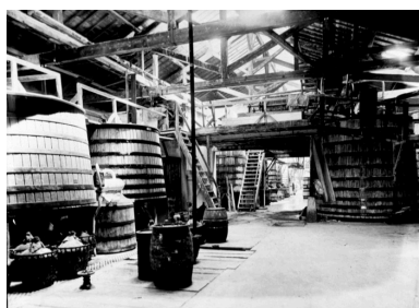
Vue des cuves de stockage des grandes caves de Lyon, BM Lyon-vidéralp collection Sylvestre 1930 Phot. Didier Nicolle IVR82_20036901553NUC
