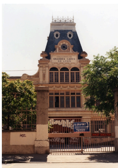
Vue nord du pavillon centrale Phot. Nadine Halitim-Dubois IVR82_20086901818NUCA
