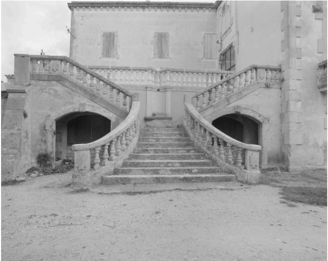
Le grand escalier extérieur.
