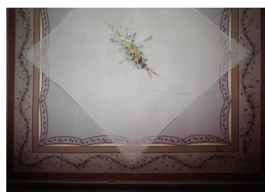
Le plafond d'une chambre. Phot. Alain Franchella IVR82_19992600667PA
