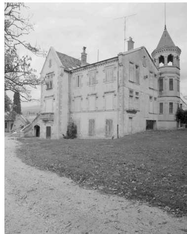
Vue de 3/4 de la maison. Phot. Alain Franchella IVR82_19982600613X
