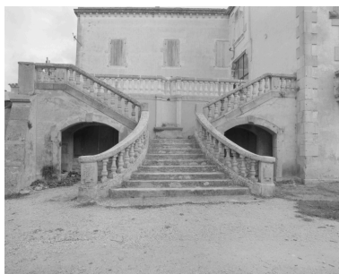
Le grand escalier extérieur. Phot. Alain Franchella IVR82_19982600612X
