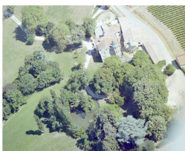
Vue aérienne. Phot. Alain Franchella IVR82_20002601325XE
