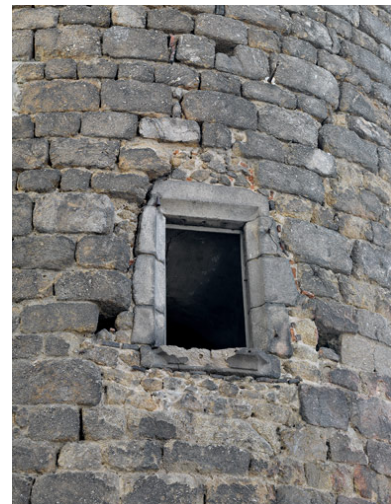
Fenêtre du 16e siècle Phot. Eric Dessert IVR82_20104200341NUCA
