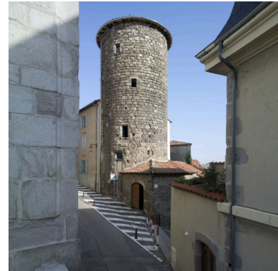
Vue d'ensemble de la tour de la Barrière depuis la rue du Palais de Justice. Phot. Didier Gourbin IVR82_20064200866NUCA
