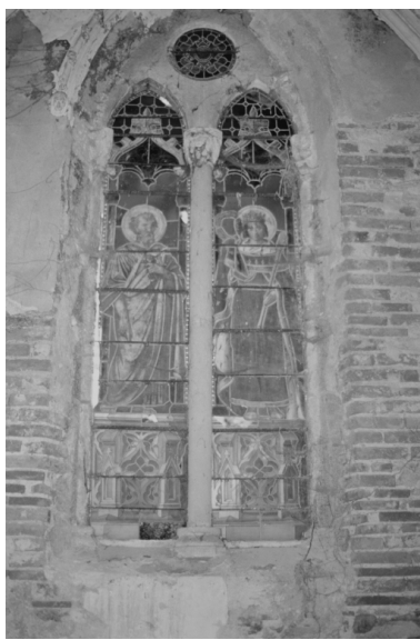
Vue d'ensemble de la baie n°1 : saint Pierre, saint Louis, depuis l'intérieur.
