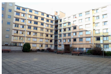
Elévations sur cour Phot. Maryannick Chalabi IVR82_20116904148NUCA
