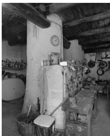
La Mège. Rez-de-chaussée : détail du pilier soutenant la charpente. Phot. Alain Franchella IVR82_20002600082X
