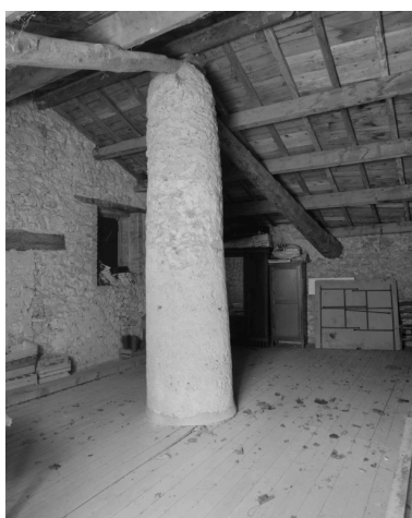
La Mège. Comble, pilier soutenant la charpente. Phot. Alain Franchella IVR82_20002600081X
