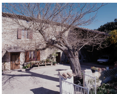
La Tuilière. Vue partielle sur cour : logis et hangar. Phot. Alain Franchella IVR82_20002600067XA
