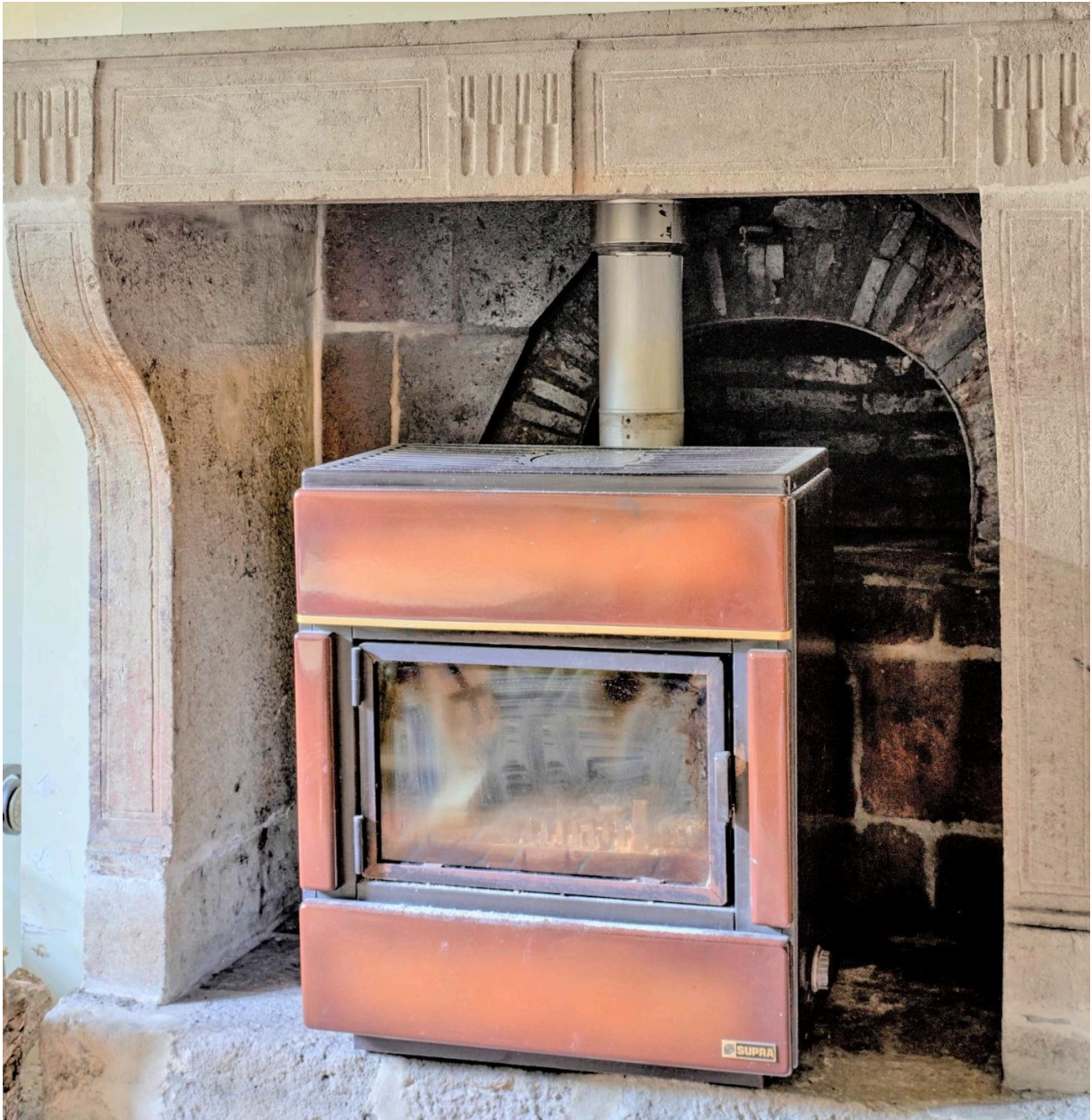
Détail du foyer de la cheminée à l'ouest du bâtiment sud contenant la porte du four à pain.
