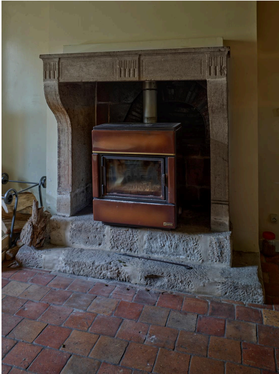
Cheminée à l'ouest du bâtiment sud.
