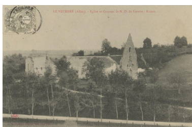
Vestiges du couvent de Notre-Dame de Lorette, au premier plan : vestiges de l'église, au second plan vestiges des bâtiments conventuels transformés en ferme. Phot. René Dovillez IVR84_20250300199NUCA
