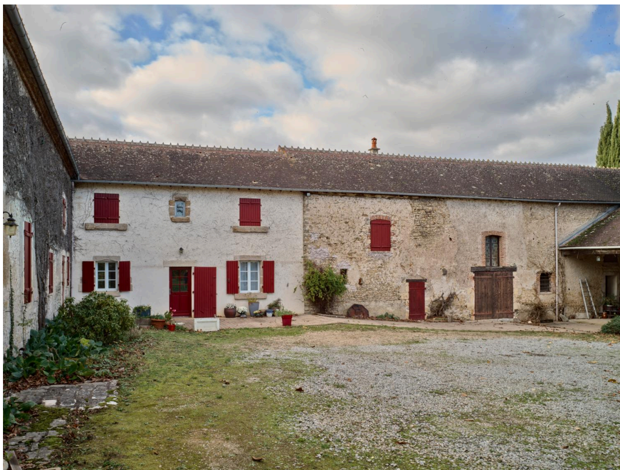
Bâtiment occidental, vue générale.
