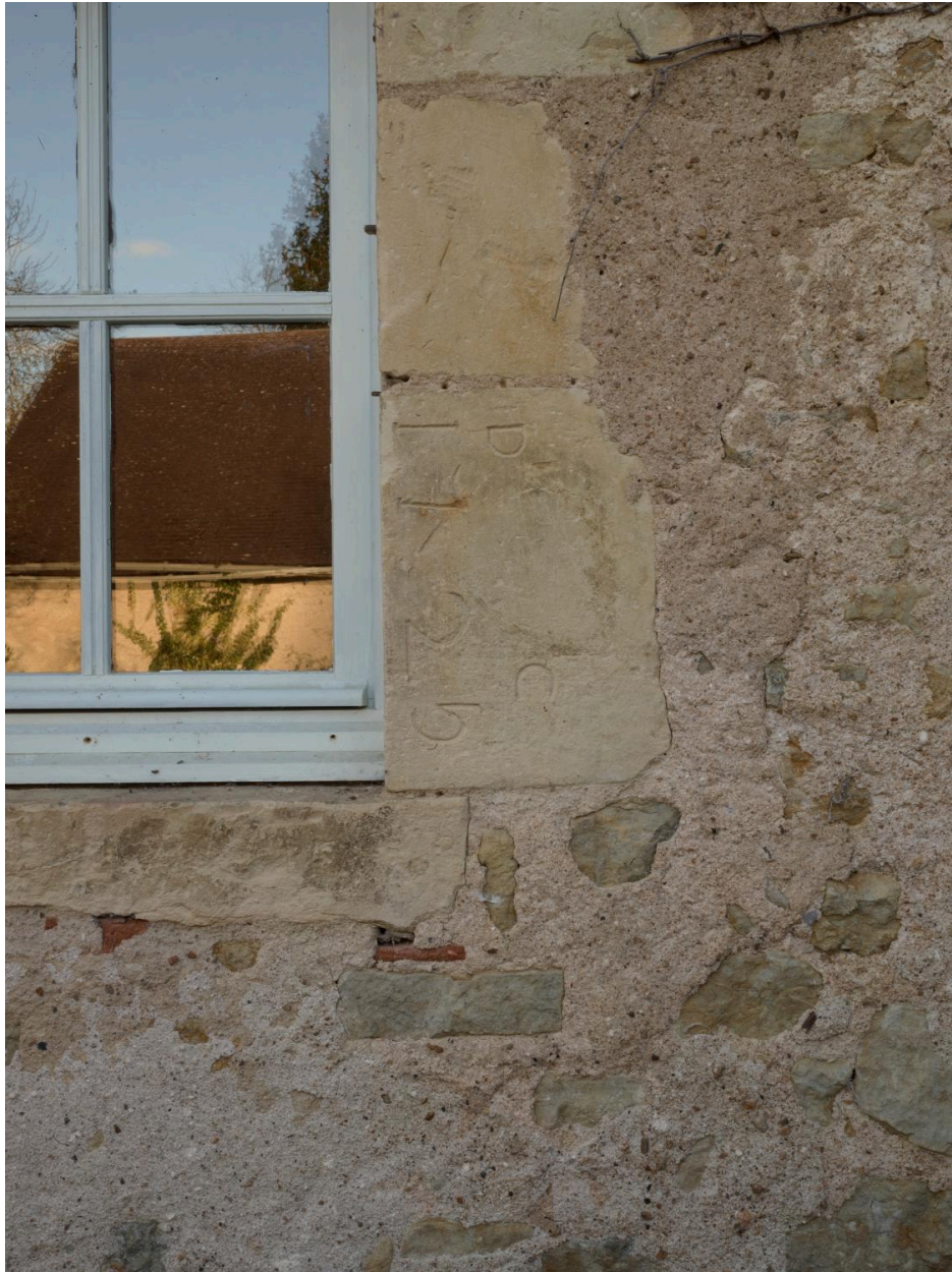
Graffitis sur le piédroit d'une baie du bâtiment sud : DC 1725.
