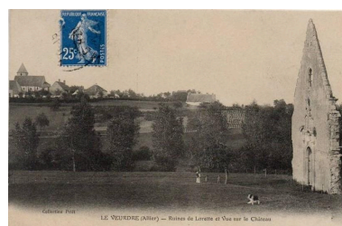
Vue des ruines du pignon occidental de l'église de Notre-Dame de Lorette, avec le bourg de Château-sur-Allier au second plan, début du 20e siècle. Phot. Petit IVR84_20250300198NUCA
