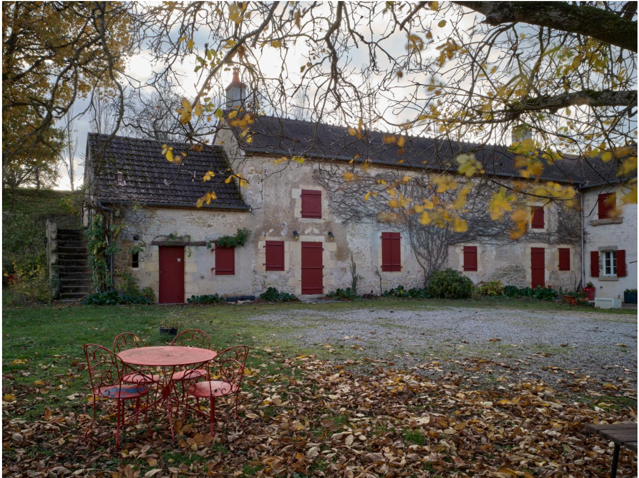
Bâtiment sud. Vue générale.
