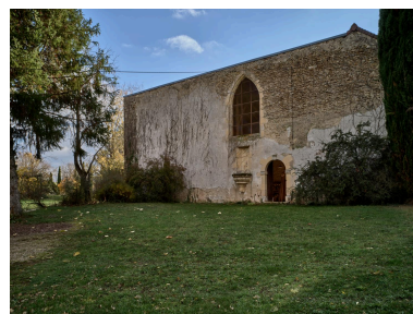
Mur gouttereau méridional subsistant de l'église détruite, sur sa face intérieure. Phot. Christian Parisey, Phot. Marion Urbanek IVR84_20230300566NUC4A
