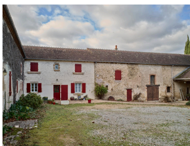
Bâtiment occidental, vue générale. Phot. Christian Parisey, Phot. Marion Urbanek IVR84_20230300568NUC4A
