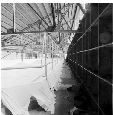
Détail charpente métallique Phot. Martial Couderette IVR82_20016903205X
