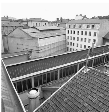
Ateliers et sheds, vue est Phot. Martial Couderette IVR82_20016903199X
