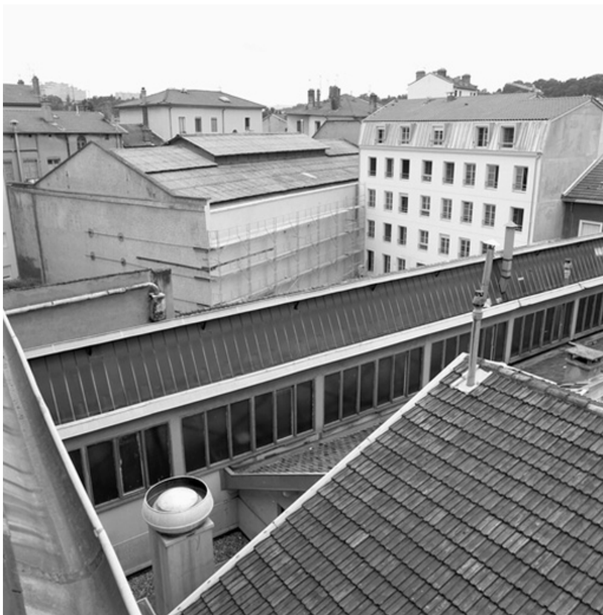
Ateliers et sheds, vue est
