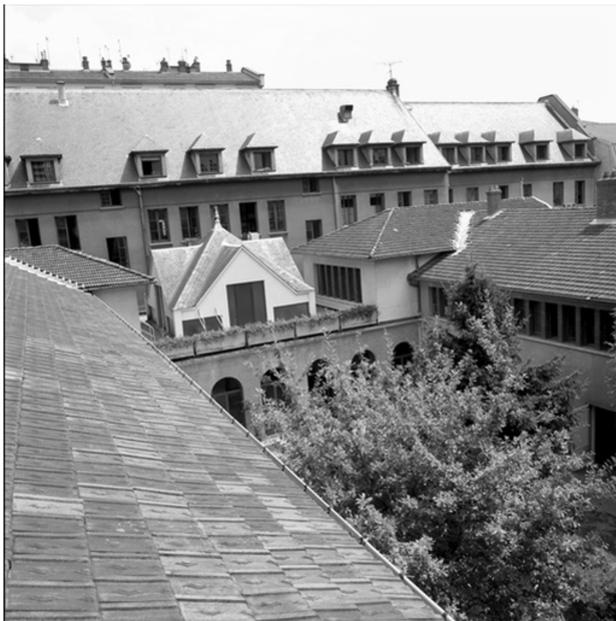
Bâtiment et cour, vue ouest
