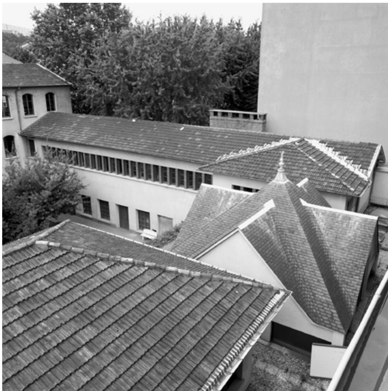
Toit du hall d'entrée construit par les compagnons
