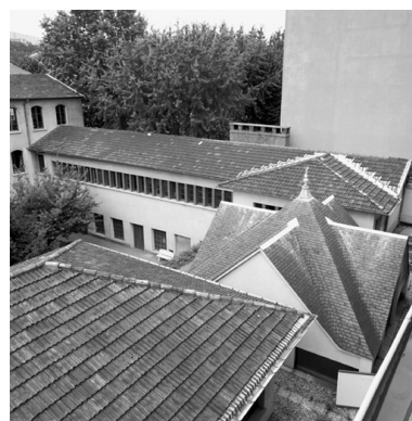
Toit du hall d'entrée construit par les compagnons Phot. Martial Couderette IVR82_20016903200X
