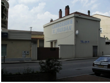
Vue générale Phot. Benoît Chapelle IVR82_20073800102NUCA
