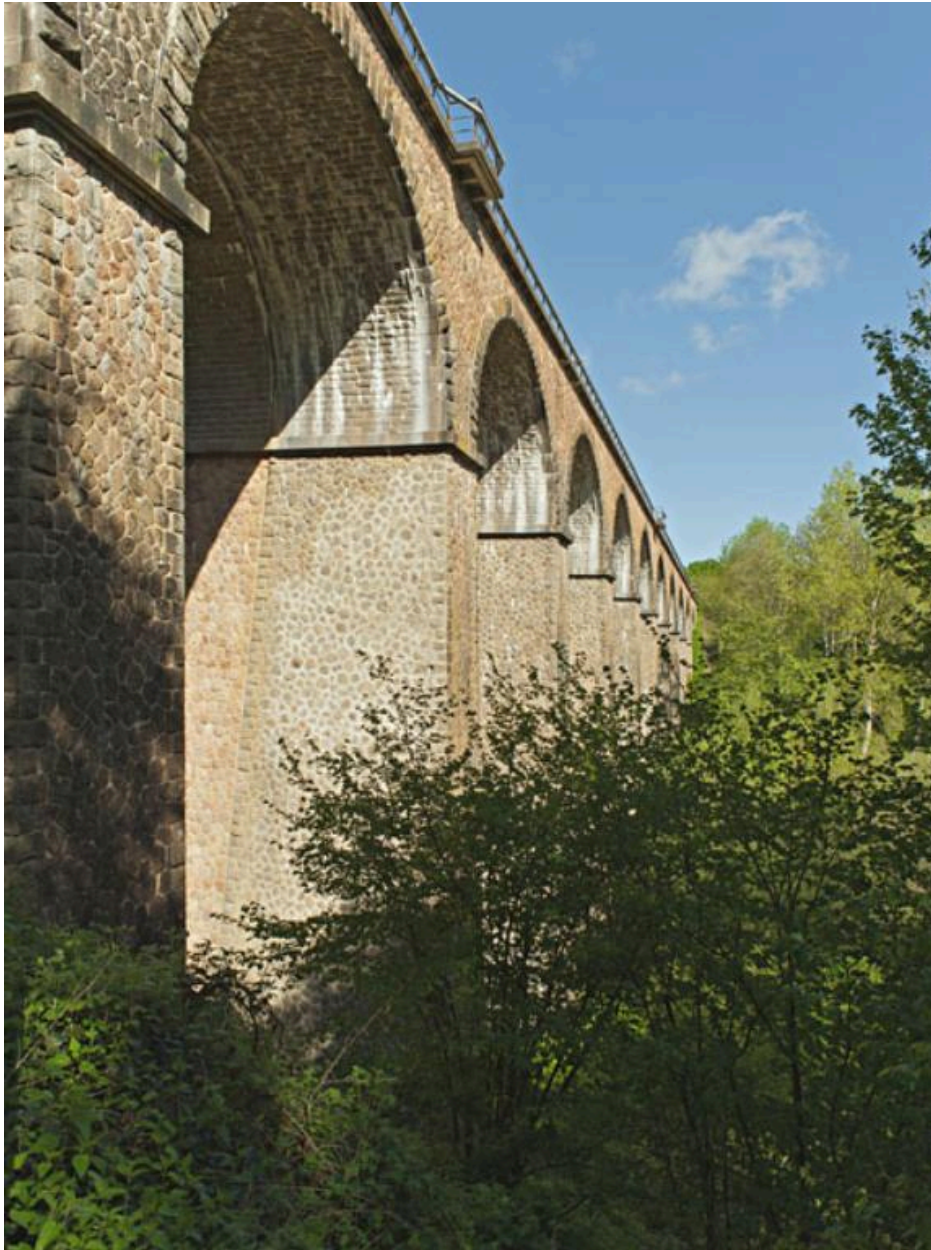
Vue du viaduc en contre-plongée, depuis la base de ses piles.
