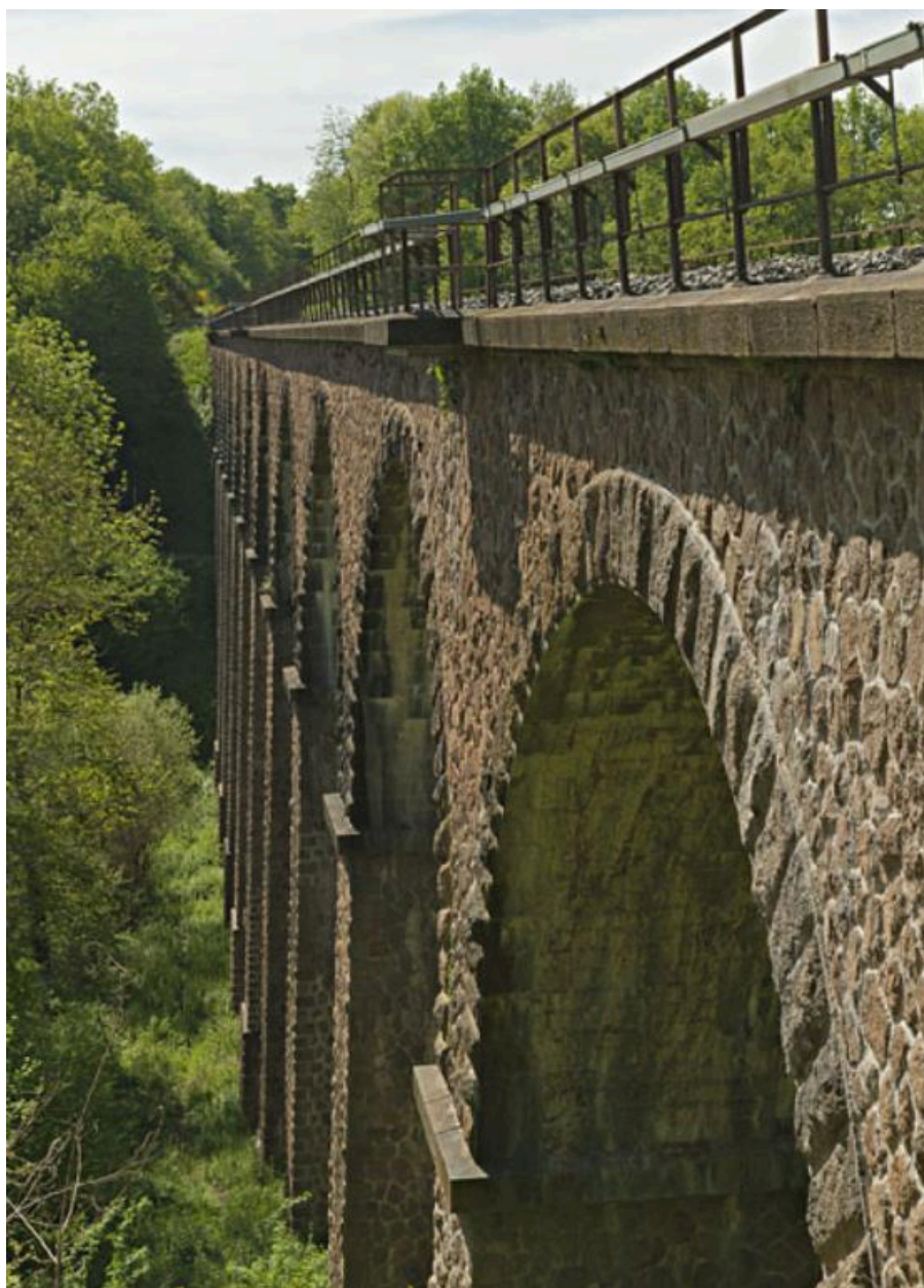
Vue du viaduc en biais, au niveau du tablier et de la voie.
