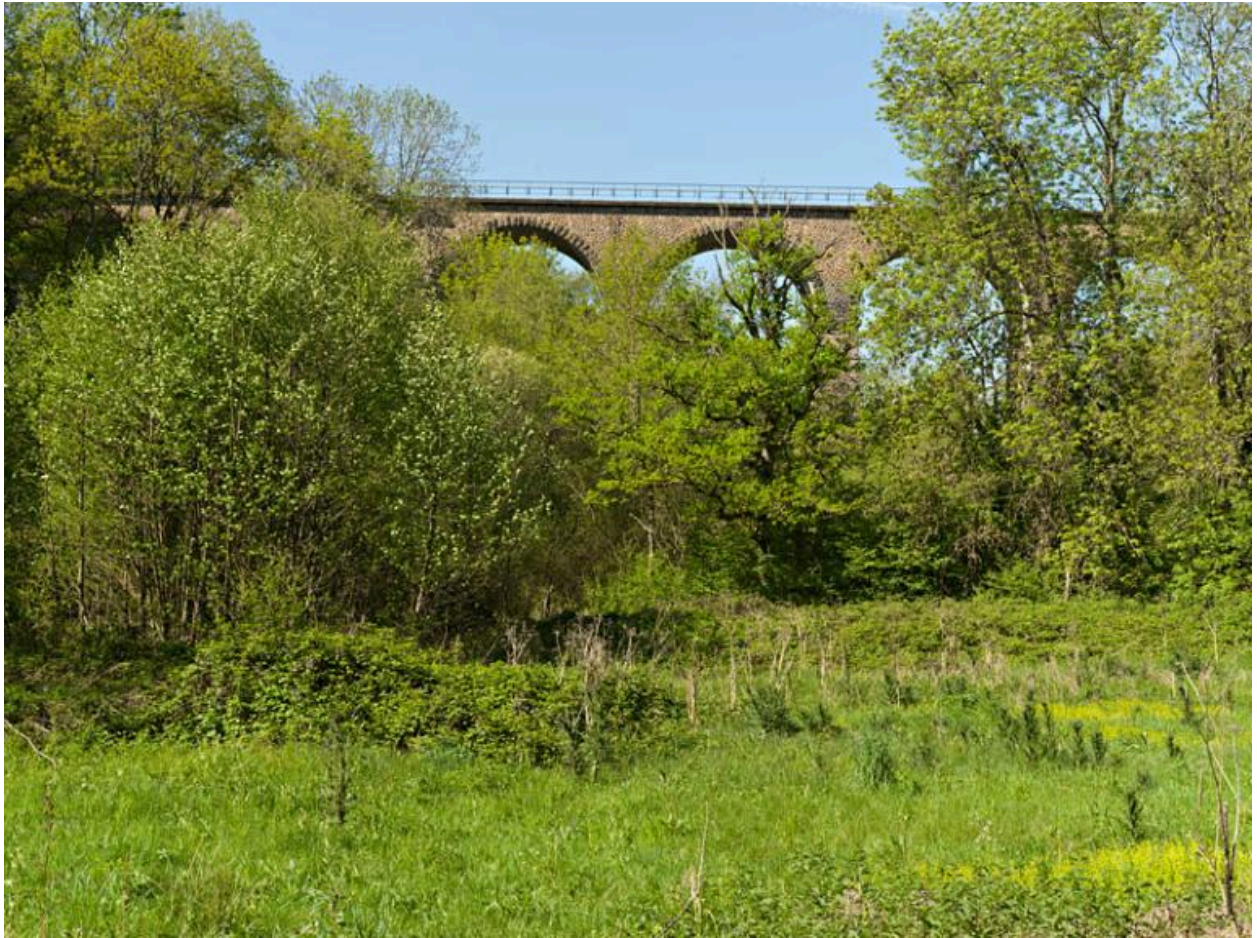
Vue générale du viaduc du Soleil depuis la vallée qu'il enjambe.
