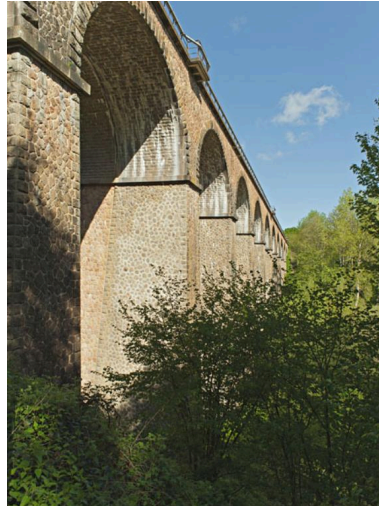
Vue du viaduc en contre-plongée, depuis la base de ses piles. Phot. Jean-Michel Périn IVR83_20150300041NUC4A
