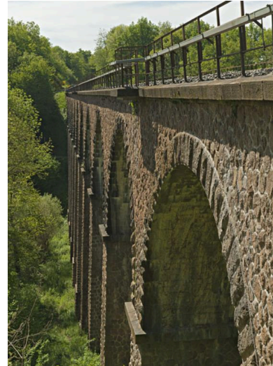
Vue du viaduc en biais, au niveau du tablier et de la voie. Phot. Jean-Michel Périn IVR83_20150300042NUC4A
