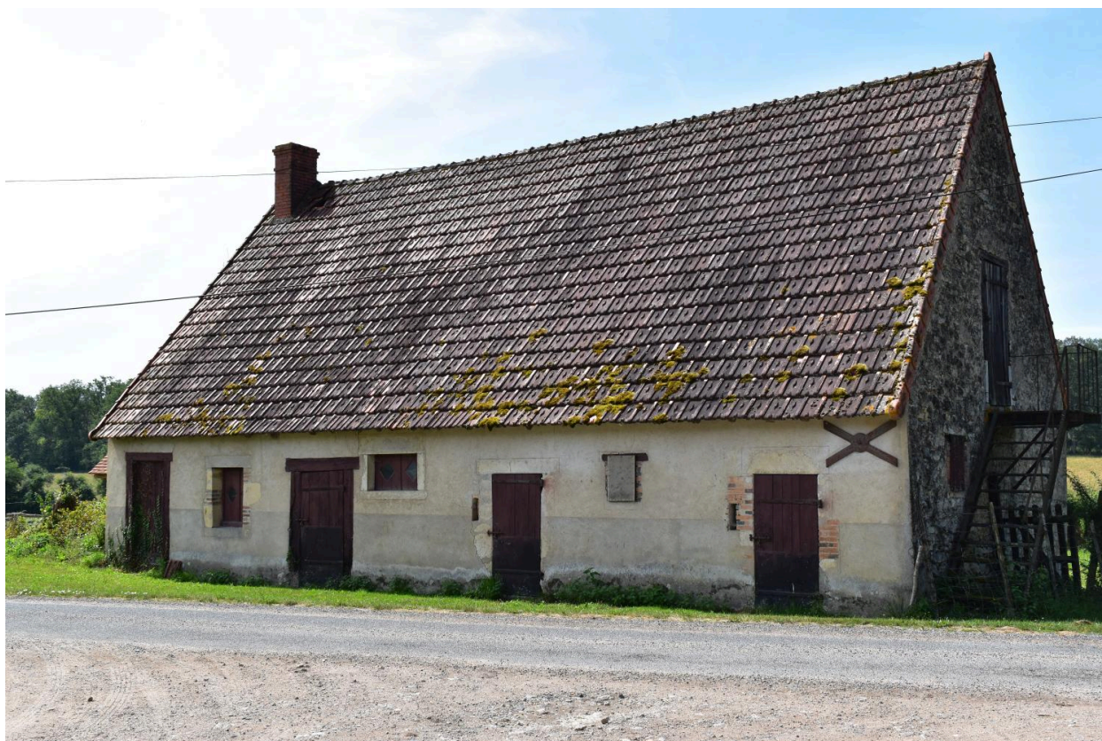
Ecart de Bazin : vue de l'ancienne maison d'habitation du domaine, à four à pain en pignon, encadrements de baies en bois, grenier au dessus, transformée en bâtiment agricole.
