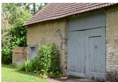
Ecart de la Marguerite : vestiges de la grange de la ferme en maison bloc, à encadrements de baies en bois, dont un linteau curviligne. 2/2 Phot. Maryse Durin-Tercelin IVR84_20250300113NUCA
