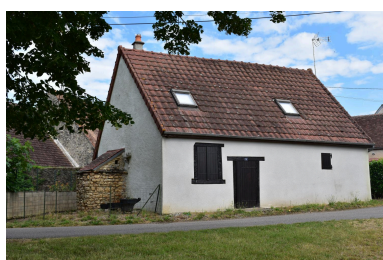
Les Roblins : maison A4 561 dont l'encadrement des baies est en bois, à four à pain adossé au pignon. Phot. Maryse Durin-Tercelin IVR84_20250300083NUCA
