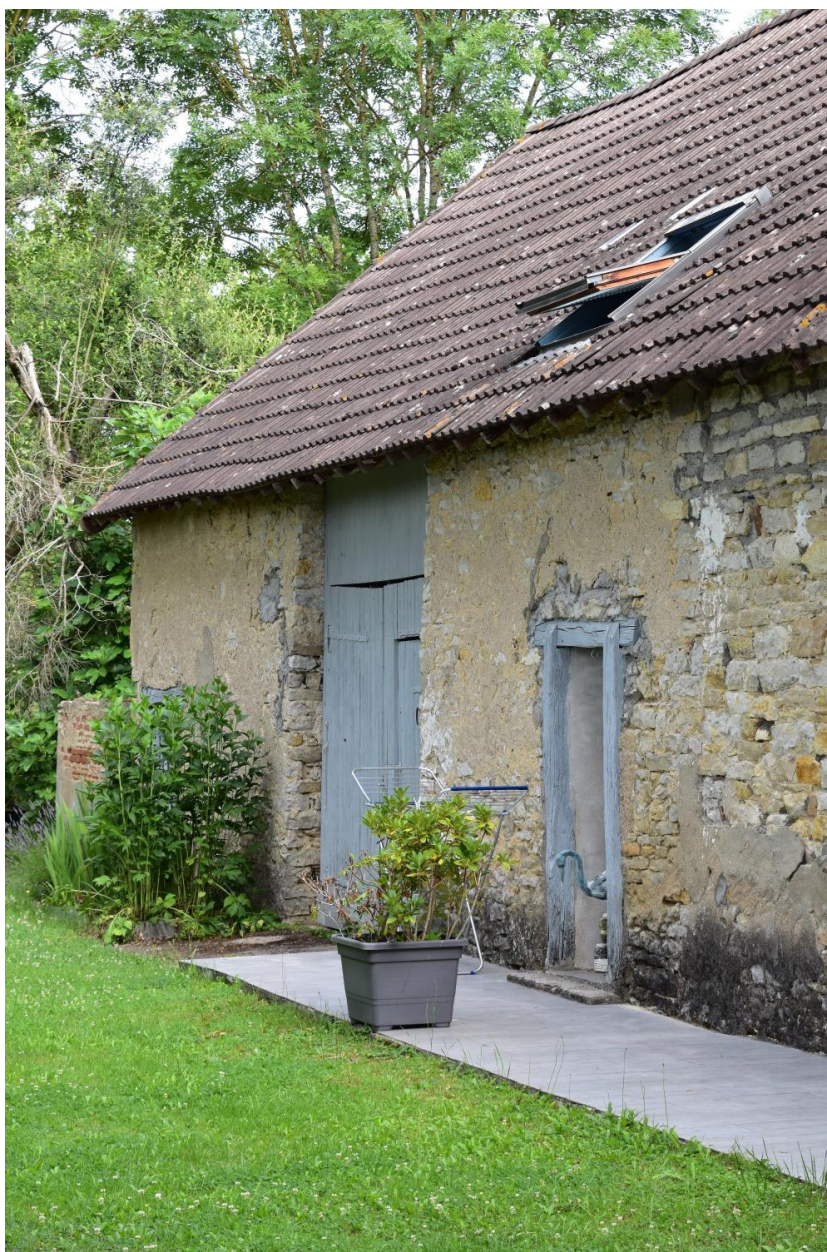
Ecart de la Marguerite : vestiges de la grange de la ferme en maison bloc, à encadrements de baies en bois, agrandie au 19e ou 20e siècle. 1/2
