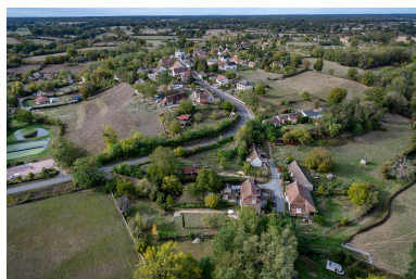
Vue aérienne par drone de la commune de Château-sur-Allier, le lieu-dit Le Pont au premier plan. Phot. Christian Parisey, Phot. Michel Pérès IVR84_20230300434NUCA
