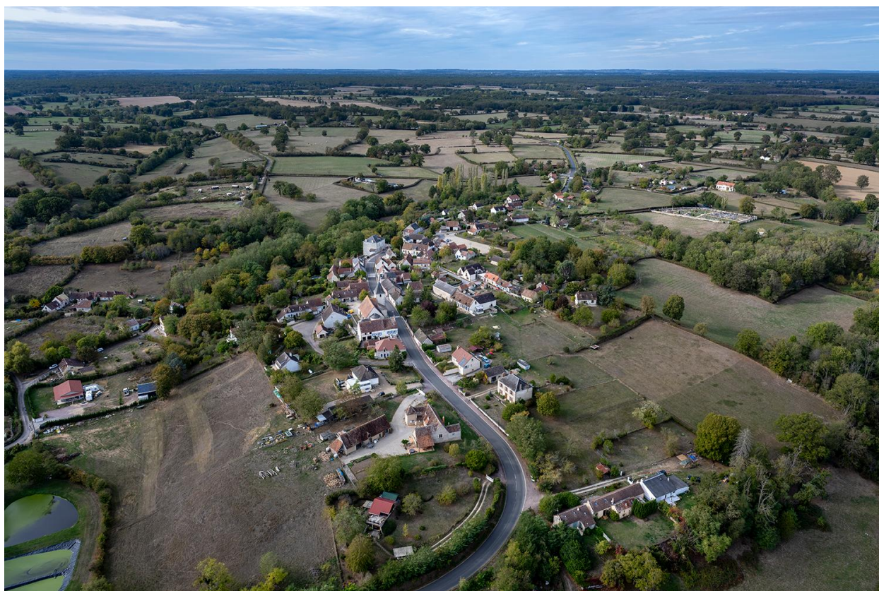
Vue aérienne par drone de la commune de Château-sur-Allier.
