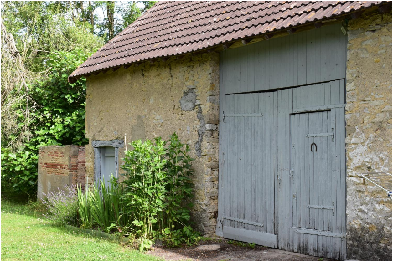
Ecart de la Marguerite : vestiges de la grange de la ferme en maison bloc, à encadrements de baies en bois, dont un linteau curviligne. 2/2
