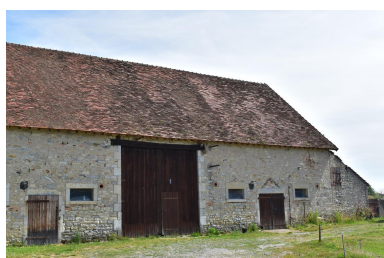
Grange du domaine de Bazin 2/2 Phot. Maryse Durin-Tercelin IVR84_20250300117NUCA
