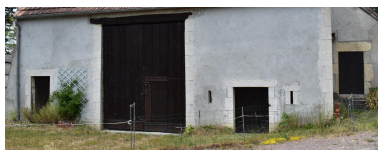
Pierres de taille de calcaire présentant des moulures en cavet sur la façade d'un bâtiment agricole de la Plante Saint-Blaise à l'emplacement d'un établissement religieux (prieuré?). Phot. Maryse Durin-Tercelin IVR84_20250300054NUCA
