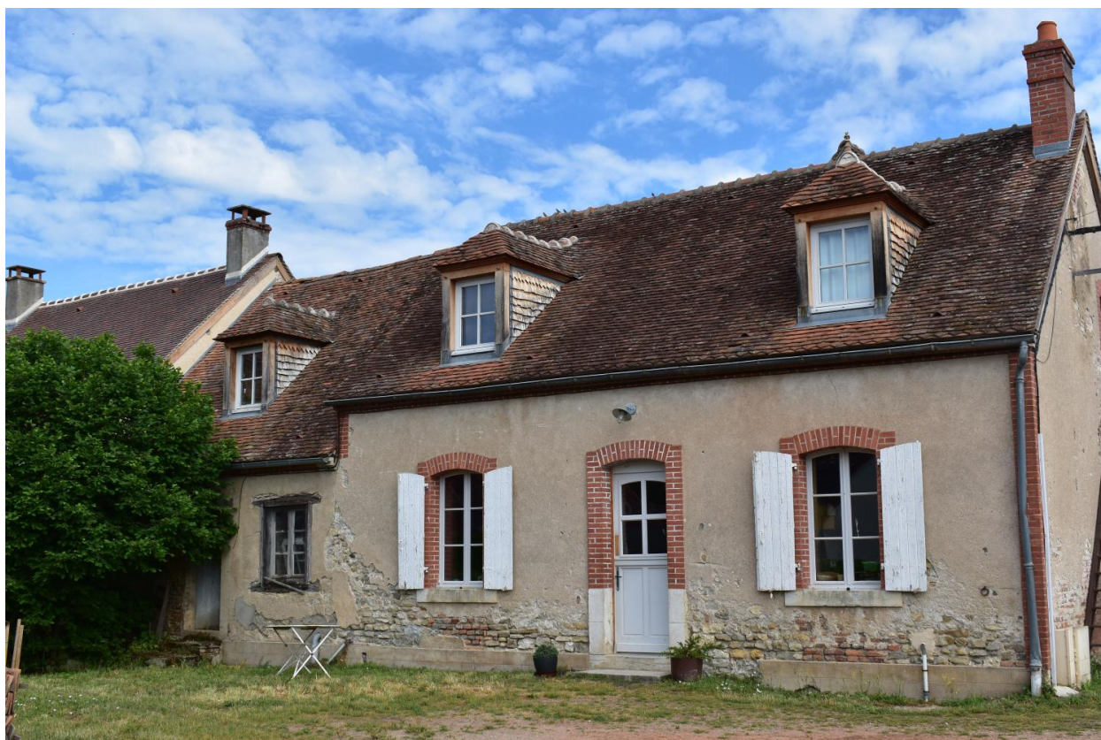
Les Roblins : maison A4 560 dont la partie occidentale possède un encadrement de fenêtre en bois.
