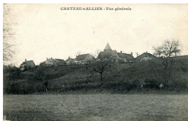
Carte postale : vue générale du bourg de Château-sur-Allier depuis le nord-ouest. 1er quart du 20e siècle. IVR84_20230300308NUCA
