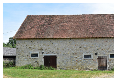
Grange du domaine de Bazin 1/2 Phot. Maryse Durin-Tercelin IVR84_20250300116NUCA
