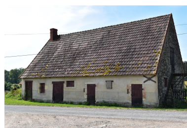
Ecart de Bazin : vue de l'ancienne maison d'habitation du domaine, à four à pain en pignon, encadrements de baies en bois, grenier au dessus, transformée en bâtiment agricole. Phot. Maryse Durin-Tercelin IVR84_20250300115NUCA
