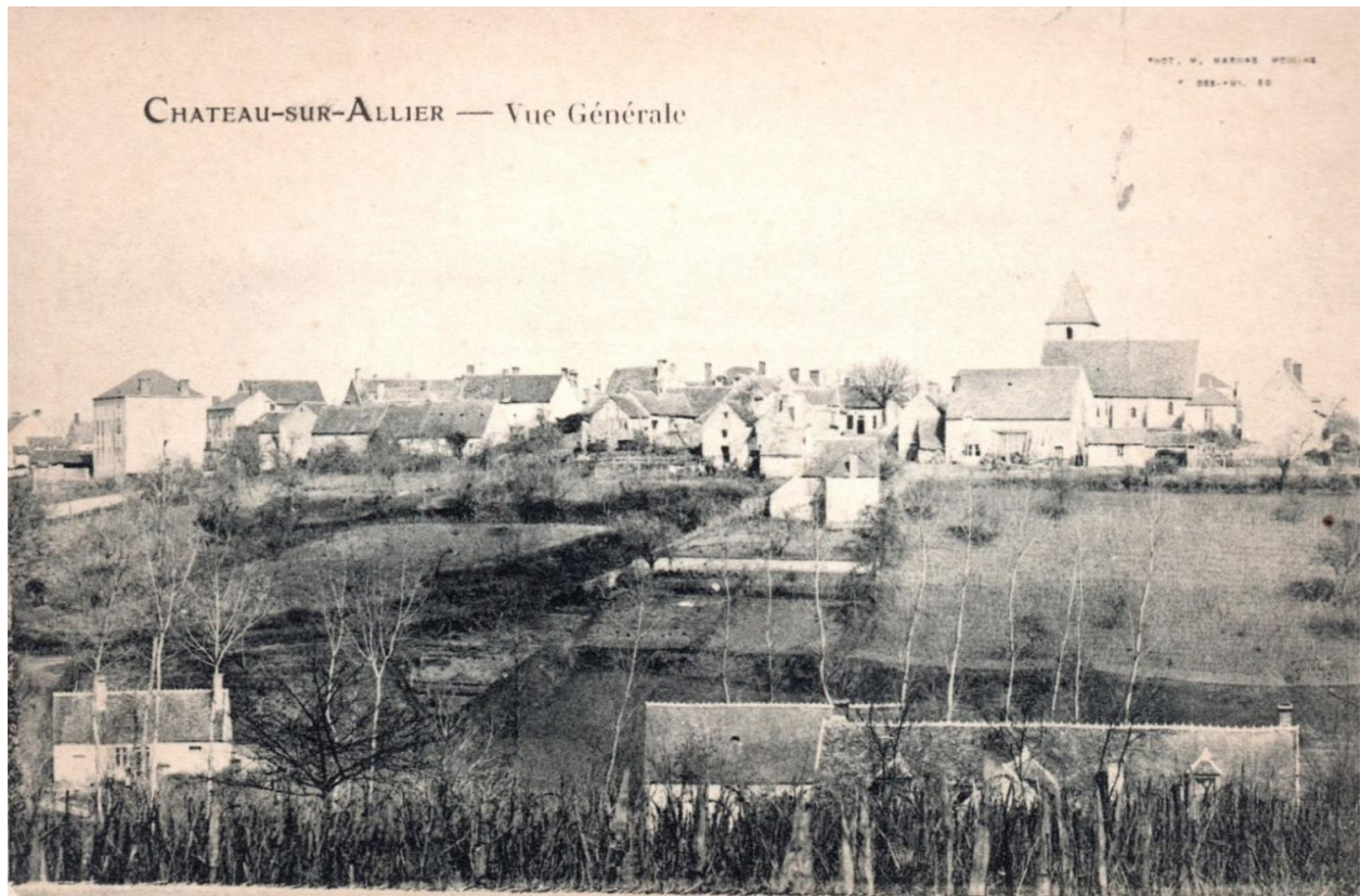
Carte postale : Château-sur-Allier : Vue générale [depuis le Lieu Carobe] vers 1900-1906
