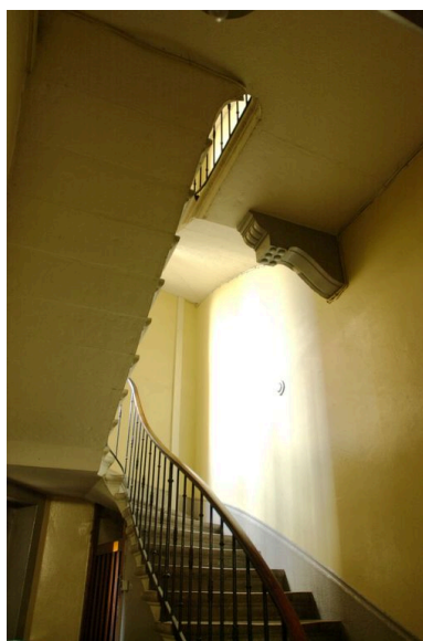
Vue de la cage d'escalier et du palier soutenu par une console Phot. Maryannick Chalabi IVR82_20086900635NUCA
