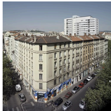
Vue d'ensemble depuis le sud-est Phot. Eric Dessert IVR82_20076902423NUCA
