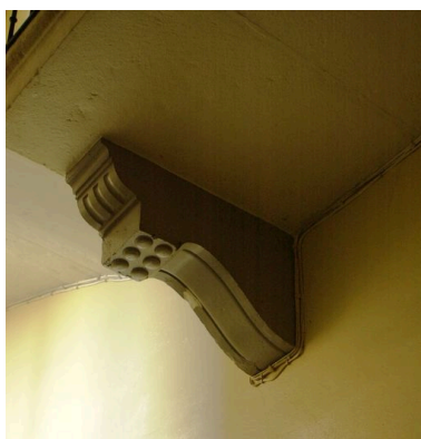
Détail d'une console moulurée soutenant le palier Phot. Maryannick Chalabi IVR82_20086900636NUCA
