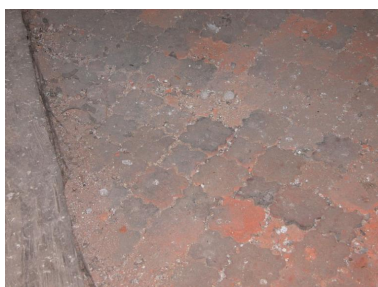
Détail des tomettes encore en place dans la pièce de l'angle sud-ouest, au 2e étage - salle +2.6 du plan schématique (photographie chercheur).
