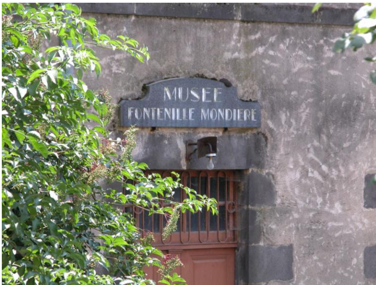
Ancienne porte d'accès au musée, dans le premier étage de soubassement - préservé lors des travaux de 2008 (photographie chercheur).
