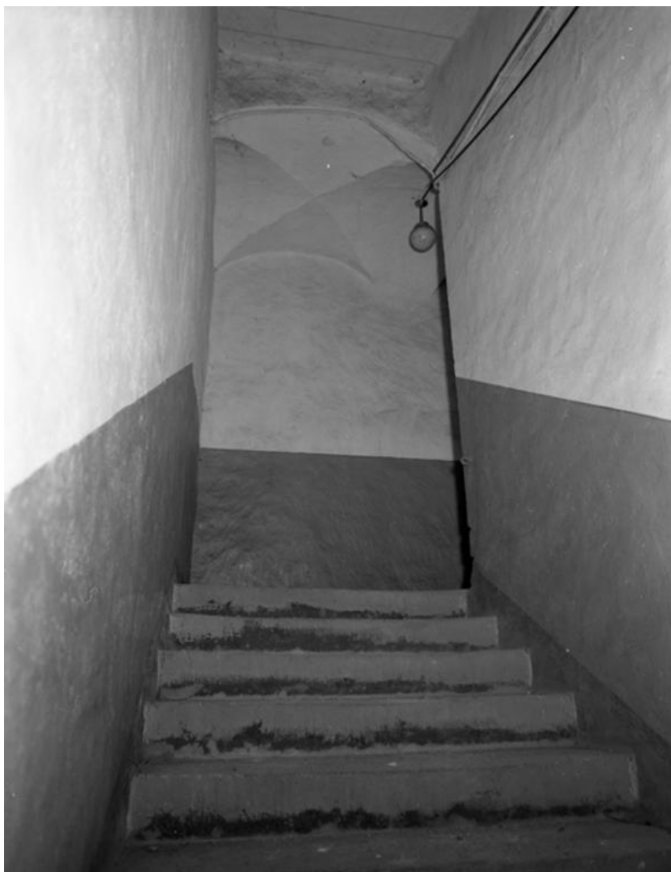
L'escalier et un palier intermédiaire voûté d'arêtes, entre le 2e et le 1er étage de soubassement, préservés lors des travaux de 2008.
