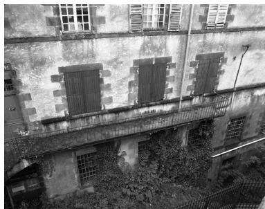
Travées de l'élévation nord, aujourd'hui partiellement détruite. On aperçoit en particulier le 1er étage de soubassement, au niveau du balcon, et au-dessous, les 2e (fenêtres grillagées) et 3e niveaux de soubassement (photographie chercheur). Phot. Jean-Michel Périn IVR83_20066300807X
