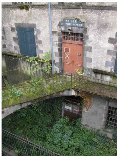
Passerelle d'accès à l'ancien musée de la ville, au 1er étage de soubassement de l'édifice. Cette passerelle reliait le bâtiment à la rue de Barante, au niveau du n° 10 (photographie chercheur). Phot. Brigitte Ceroni IVR83_20086304203NUCA
