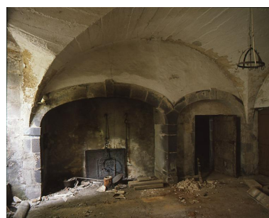
Partie de la salle voûtée d'arêtes, dite "des Visitandines", au 2e étage de soubassement - préservé lors des travaux de 2008 (salle -2.1 du plan schématique). Phot. Jean-Michel Périn IVR83_20076300143XA
