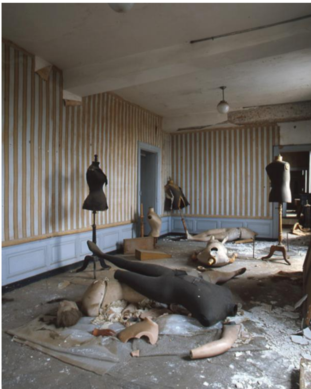
La salle du 1er étage située à l'angle sud-ouest du bâtiment - détruite lors des travaux de 2008 (salle +1.6 du plan schématique).
