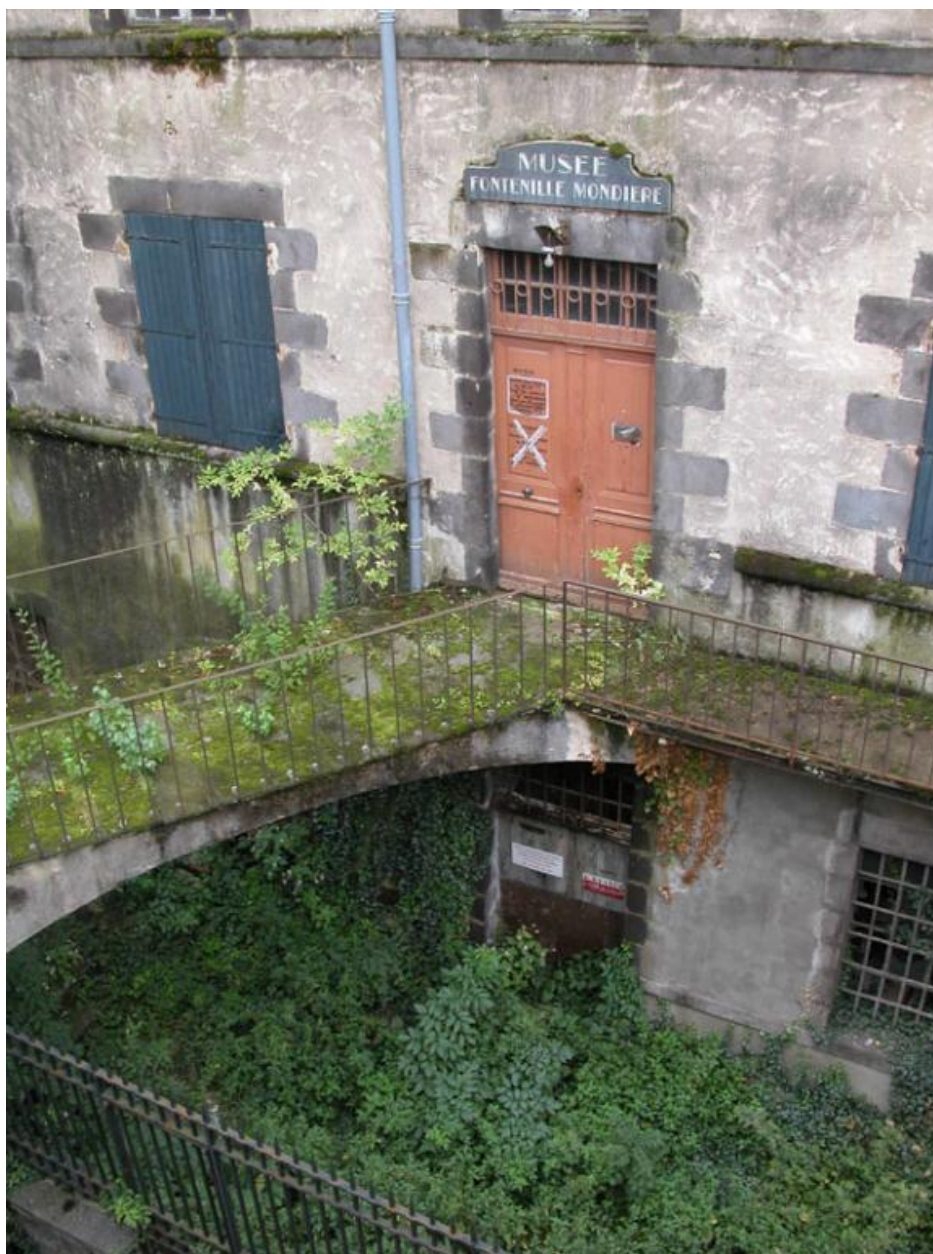
Passerelle d'accès à l'ancien musée de la ville, au 1er étage de soubassement de l'édifice. Cette passerelle reliait le bâtiment à la rue de Barante, au niveau du n° 10 (photographie chercheur).
