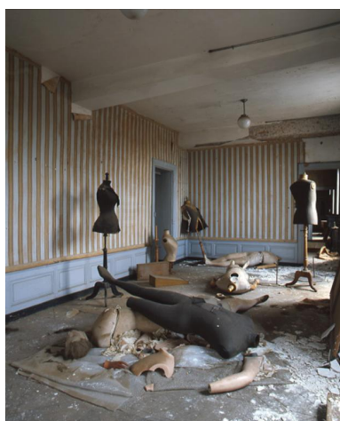
La salle du 1er étage située à l'angle sud-ouest du bâtiment - détruite lors des travaux de 2008 (salle +1.6 du plan schématique). Phot. Jean-Michel Périn IVR83_20076300153XA
