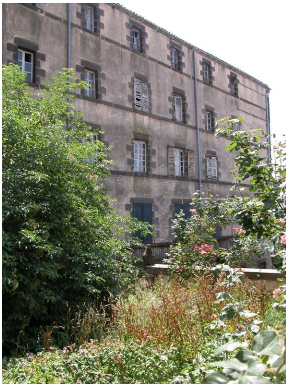
L'élévation nord avant démolition (photographie chercheur).
