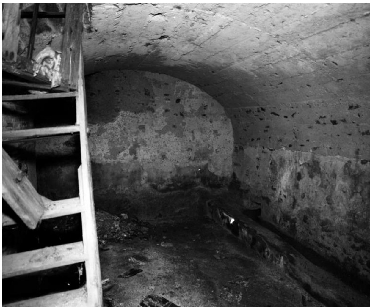
La salle voûtée en berceau à l'est du bâtiment, au 2e étage de soubassement - préservé lors des travaux de 2008 (salle -2.2 du plan schématique).
