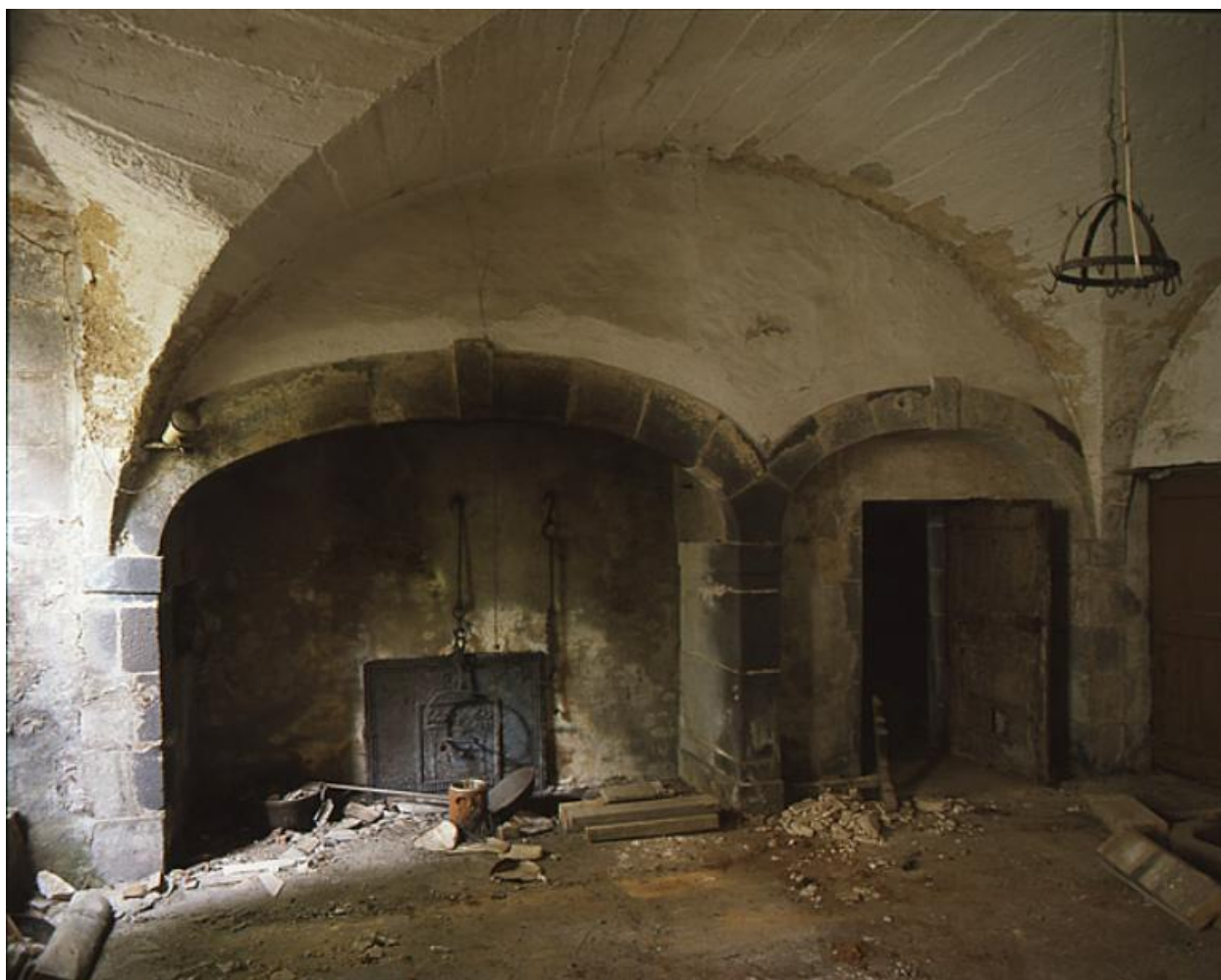
Partie de la salle voûtée d'arêtes, dite "des Visitandines", au 2e étage de soubassement - préservé lors des travaux de 2008 (salle -2.1 du plan schématique).
