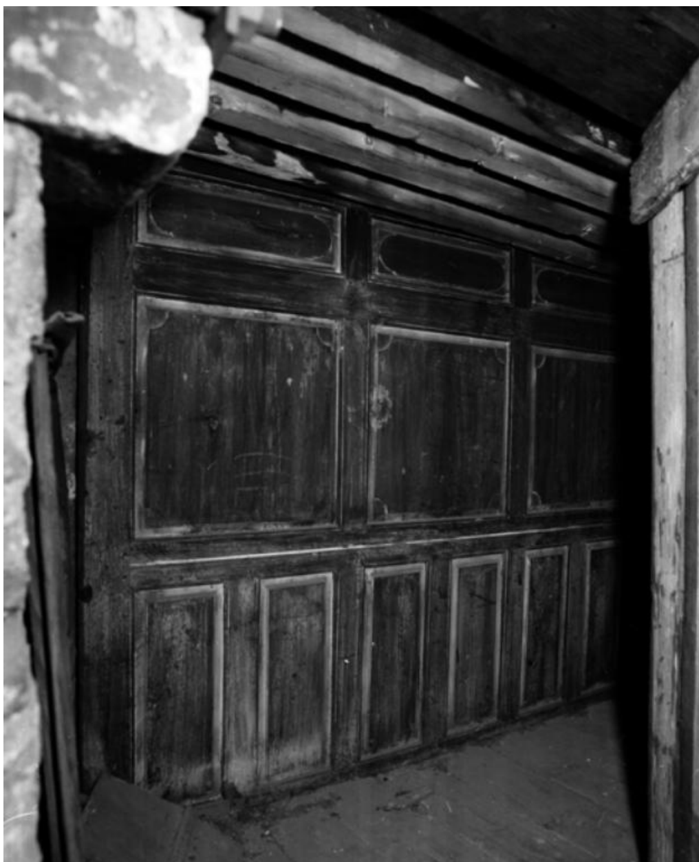
Vestiges de boiseries du 2e étage, détruit lors des travaux de 2008 (espace +2.3 du plan schématique).
