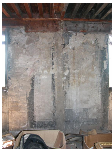
Vestiges de faux panneaux peints en gris sur fond blanc dans la pièce
