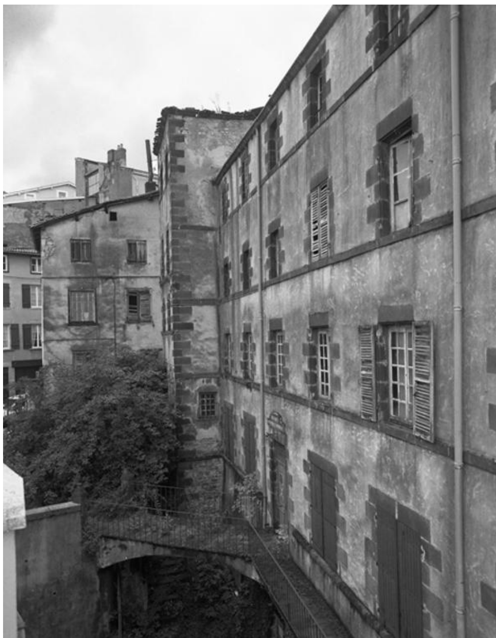
L'élévation nord aujourd'hui partiellement détruite, depuis le nord-ouest.
