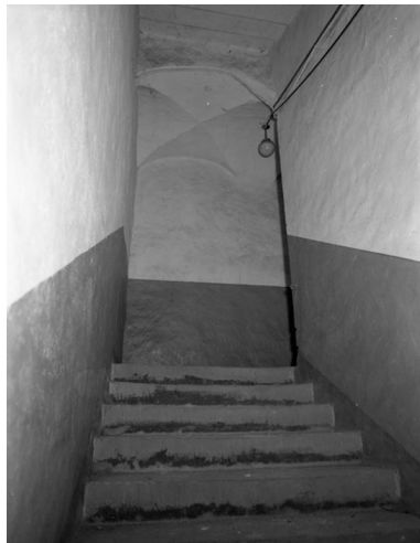
L'escalier et un palier intermédiaire voûté d'arêtes, entre le 2e et le 1er étage de soubassement, préservés lors des travaux de 2008. Phot. Jean-Michel Périn IVR83_20076300161X
