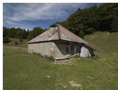
Vue du bâtiment d'habitation, façade principale. Phot. Eric Dessert IVR82_20147304392NUCA
