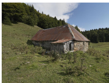
Vue du bâtiment sud. Phot. Eric Dessert IVR82_20147304393NUCA
