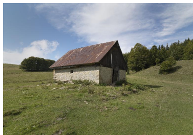
Vue du bâtiment nord : étable. Phot. Eric Dessert IVR82_20147304390NUCA
