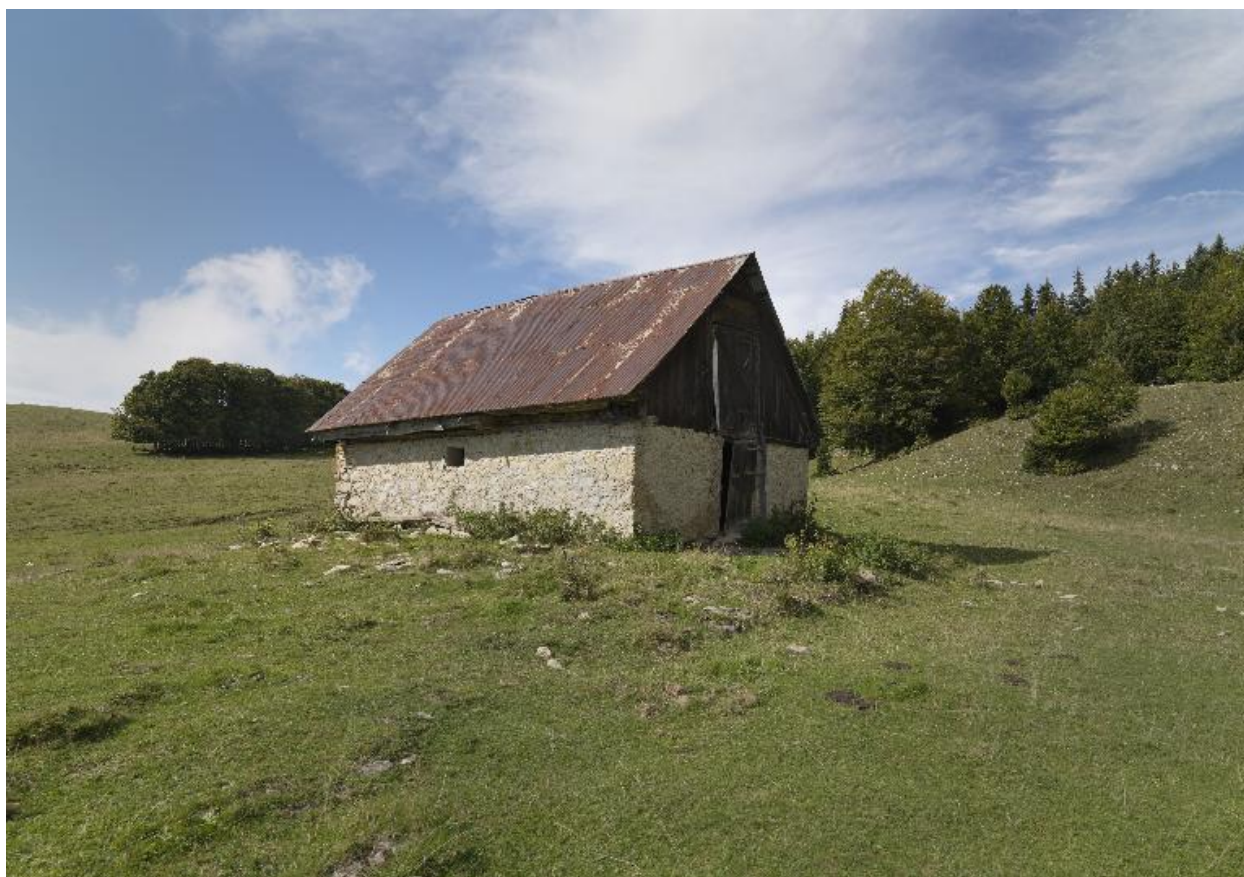
Vue du bâtiment nord : étable.
