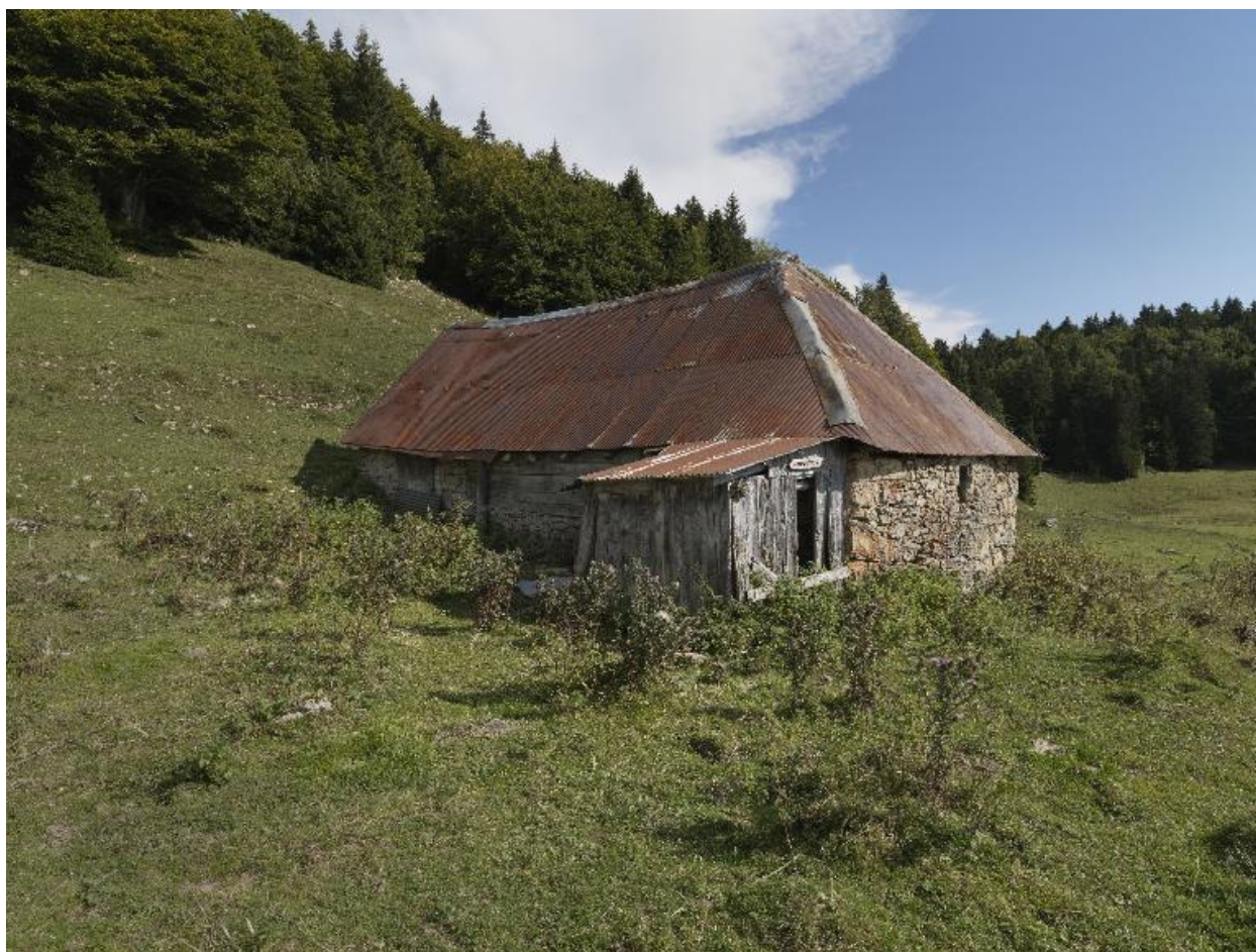
Vue du bâtiment sud.
