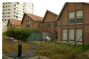
Vue depuis le sud-ouest Phot. Maryannick Chalabi IVR82_20086900661NUCA
