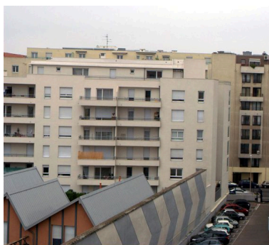
Élévation postérieure, vue partielle depuis l'est Phot. Maryannick Chalabi IVR82_20116904975NUCA
