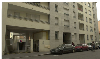
Entrée de l'immeuble rue André-Philip Phot. Maryannick Chalabi IVR82_20086900665NUCA
