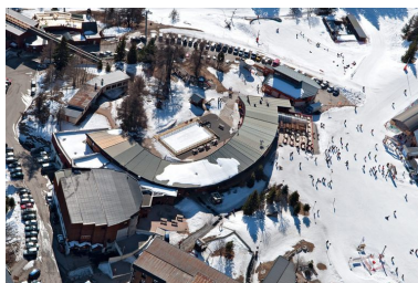
Vue aérienne verticale Phot. Eric Dessert IVR82_20117302794NUCA
