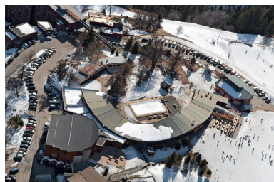
Vue aérienne verticale Phot. Eric Dessert IVR82_20117302793NUCA
