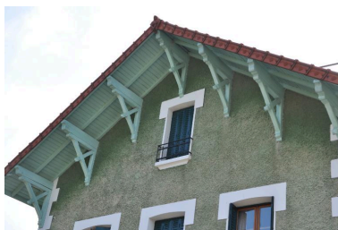
Aisseliers soutenant l'avant-toit Phot. Denys Harreau IVR82_20137300796NUCA
