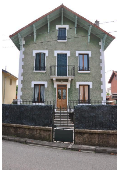
Façade principale Phot. Denys Harreau IVR82_20137300792NUCA
