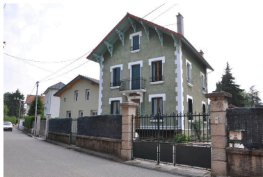
Vue d'ensemble Phot. Denys Harreau IVR82_20137300795NUCA
