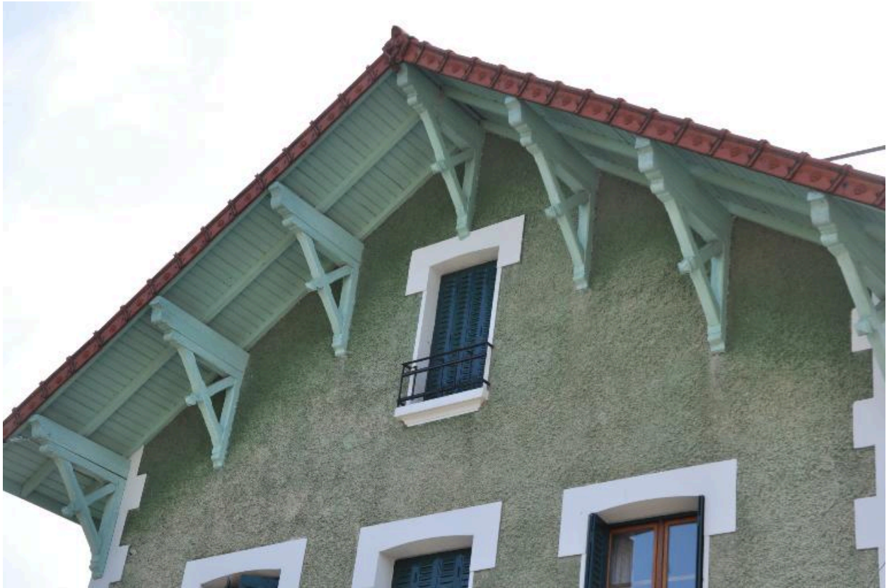
Aisseliers soutenant l'avant-toit
