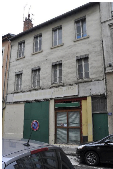
Vue générale de l'élévation sur rue Phot. Magali Delavenne IVR82_20146902930NUCA
