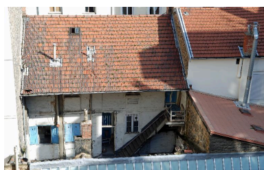
Vue générale de l'élévation sur cour Phot. Magali Delavenne IVR82_20146902934NUCA
