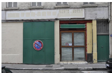
Vue rapprochée du rez-de-chaussée Phot. Magali Delavenne IVR82_20146902932NUCA
