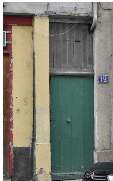
Vue rapprochée de la porte Phot. Magali Delavenne IVR82_20146902931NUCA
