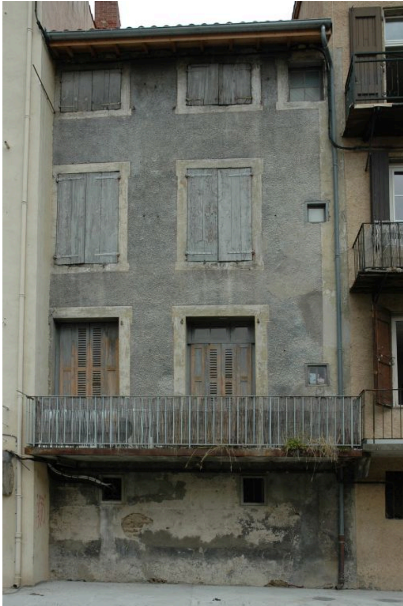
Elévation postérieure sur la rue Tupinerie.
