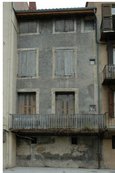
Elévation postérieure sur la rue Tupinerie. Phot. Simone Hartmann-Nussbaum IVR82_20134200546NUCA
