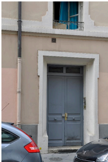
Vue rapprochée de la porte Phot. Magali Delavenne IVR84_20176901046NUCA
