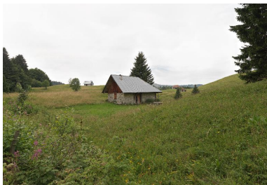
Vue générale. Phot. Thierry Leroy IVR82_20147305572NUCAQ
