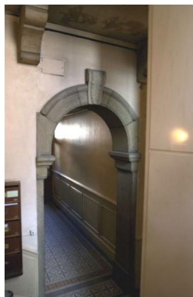
Entrée du vestibule depuis l'escalier Phot. Maryannick Chalabi IVR82_20016900406NUCA
