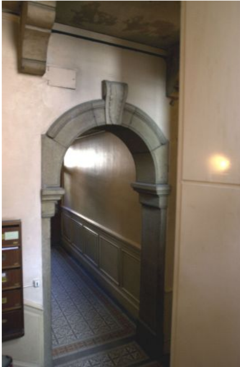
Entrée du vestibule depuis l'escalier
