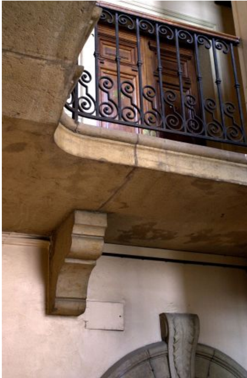
Détail d'un palier : corbeau et garde-corps
