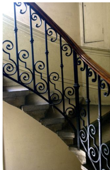
Détail de la rampe d'escalier Phot. Maryannick Chalabi IVR82_20016900409NUCA
