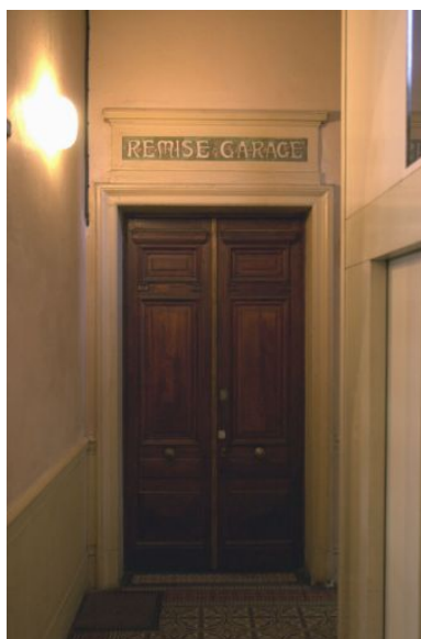
Porte des bureaux Phot. Maryannick Chalabi IVR82_20016900404NUCA
