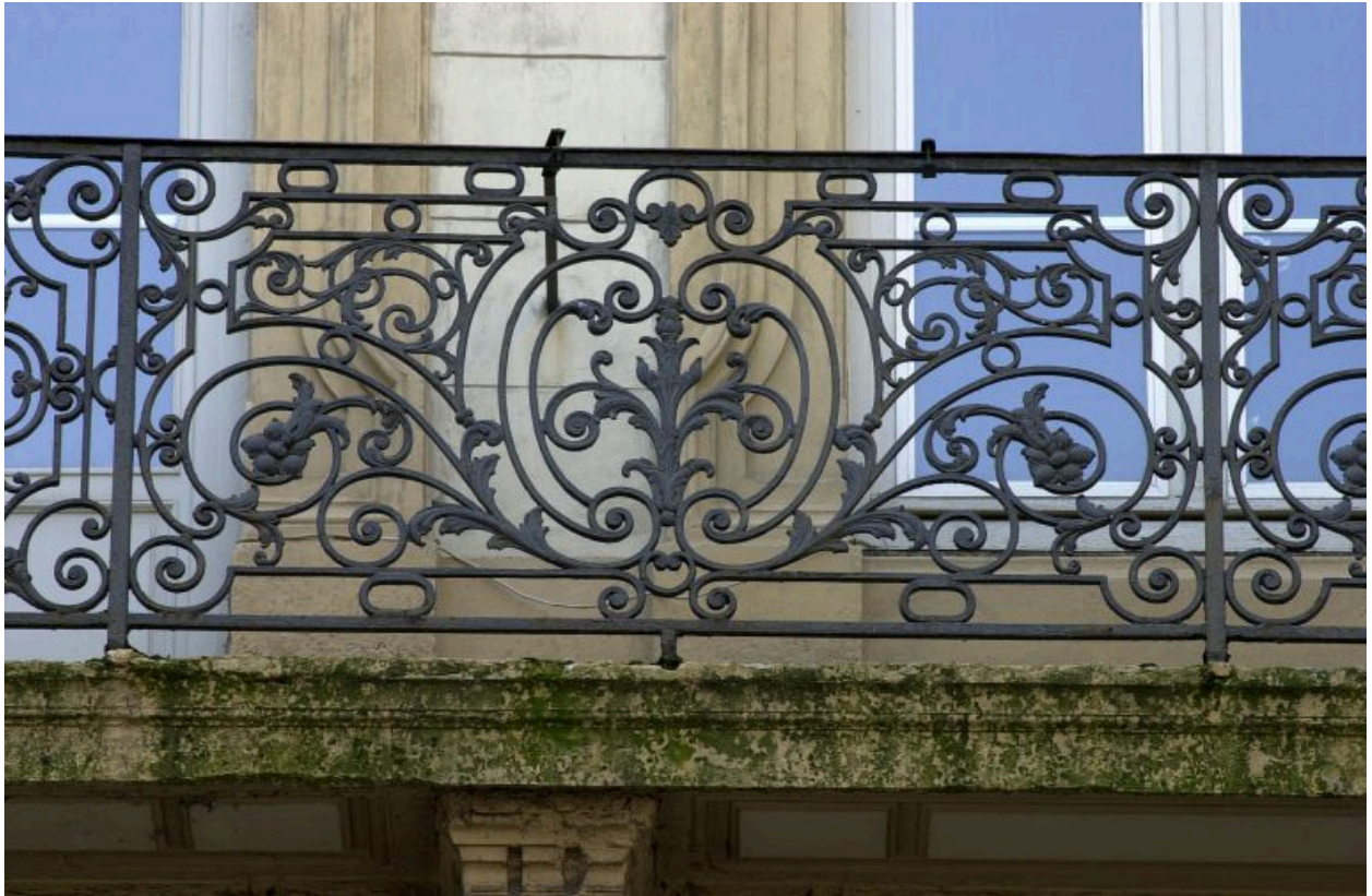
Façade principale, 3e niveau, détail du garde-corps du balcon central
