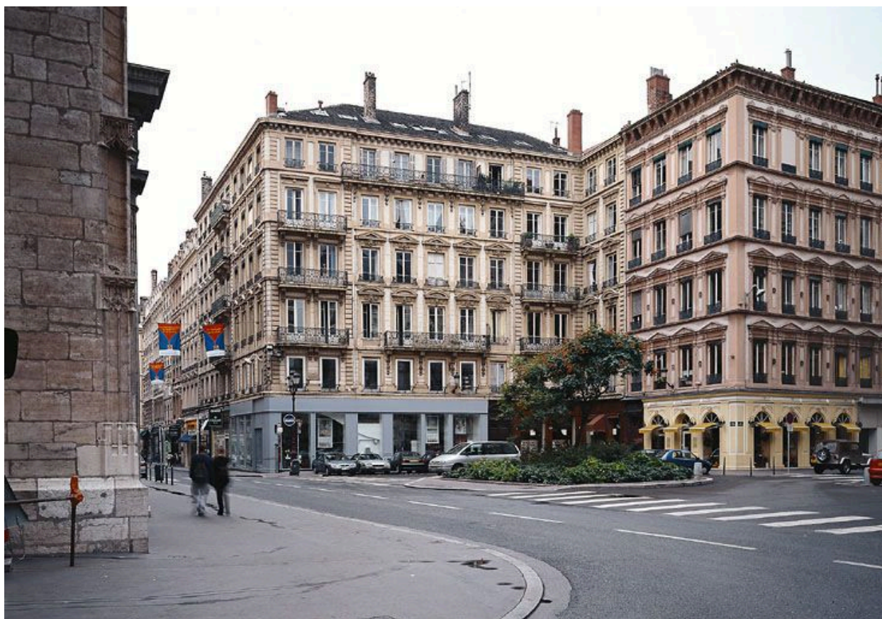
Vue générale des façades sur rue
