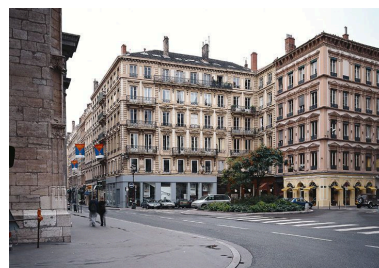
Vue générale des façades sur rue Phot. Martial Couderette IVR82_20006900436PA
