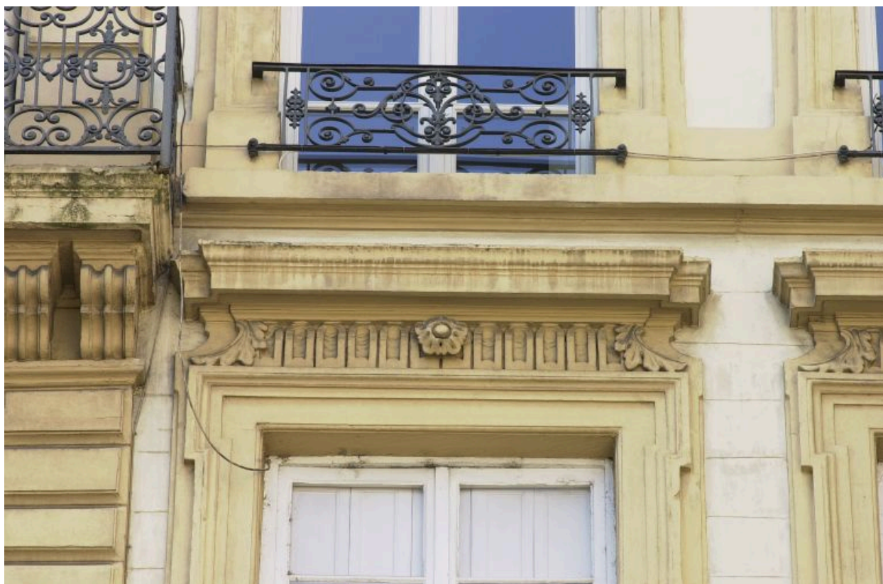
Façade principale, 5e niveau, détail de la 8e fenêtre
