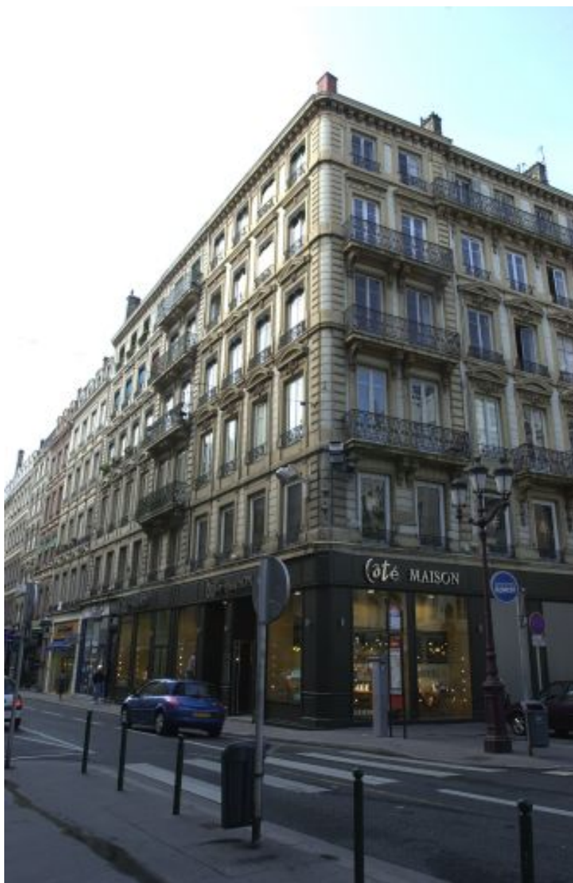
Angle des façades entre la rue de Brest et la place Saint-Nizier
