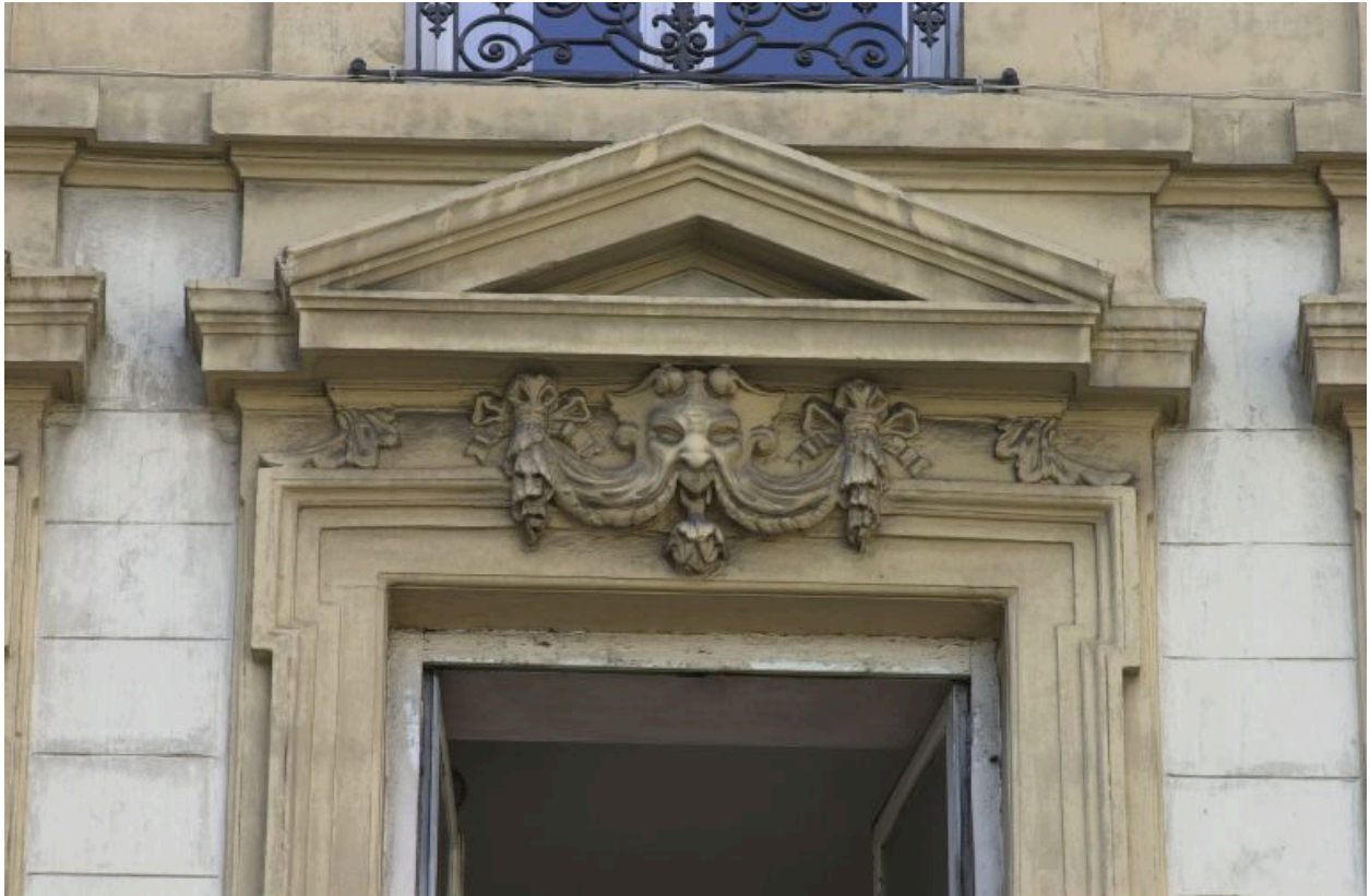
Façade principale, 4e niveau, détail de la 4e fenêtre
