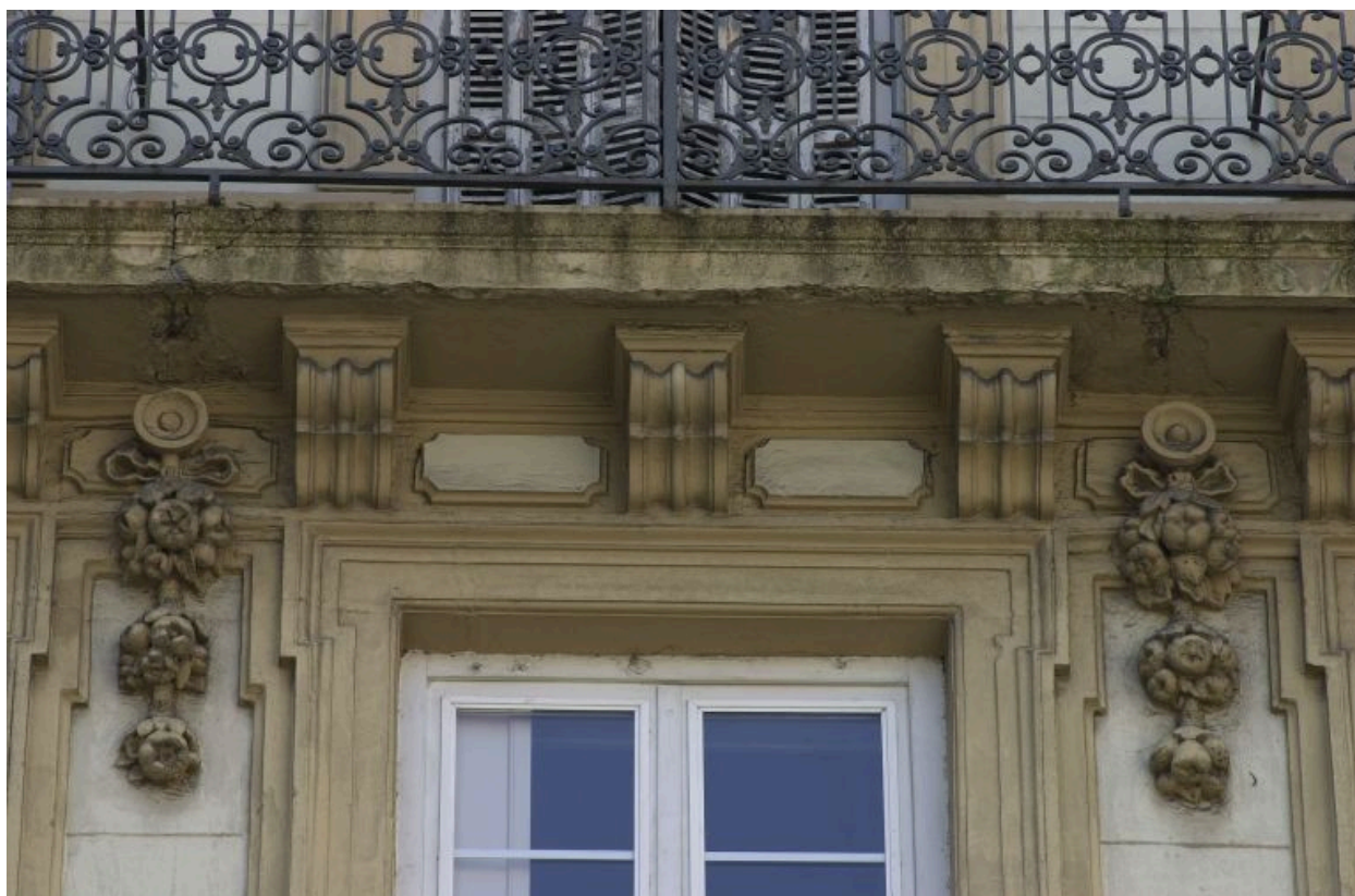
Façade principale, 5e niveau, détail de la 6e fenêtre
