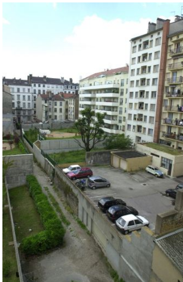
Elévation postérieure de l'immeuble cours Charlemagne Phot. François Blanchetière IVR82_20016901981NUCA
