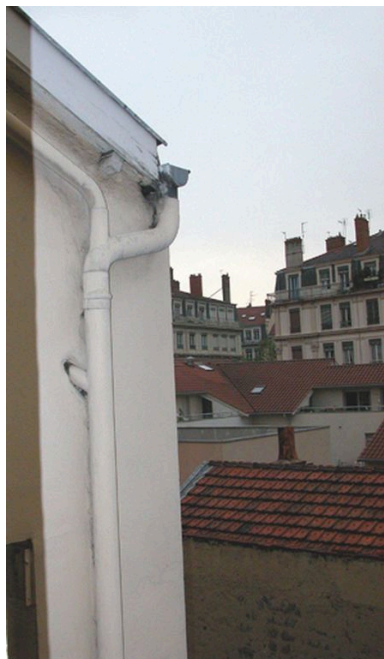
Vue des toits à l'angle de la grande rue de la Guillotière et de la rue Chalopin Phot. Maryannick Chalabi IVR82_20046904505NUCA
