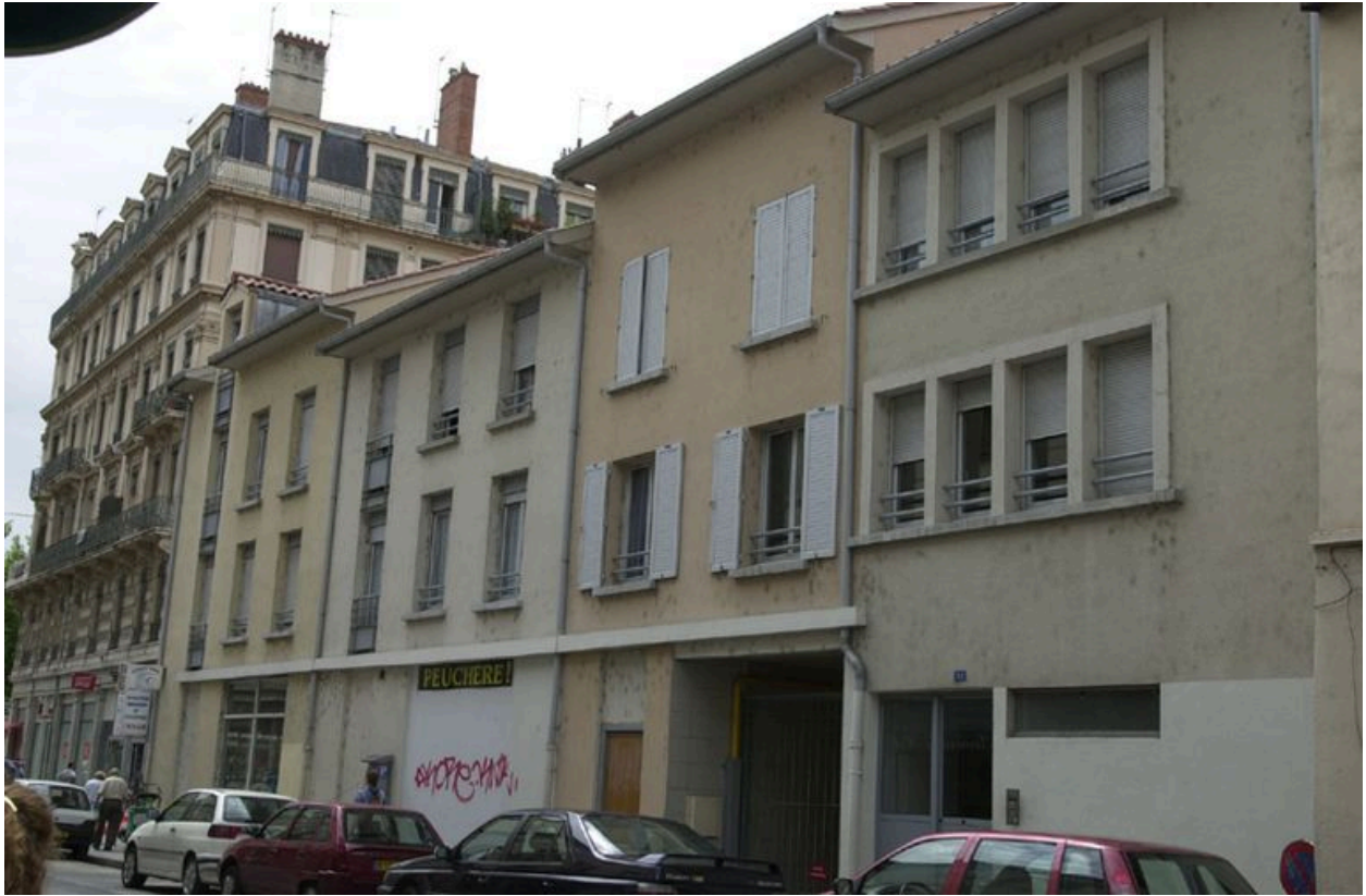
Élévation, grande rue de la Guillotière, depuis l'ouest
