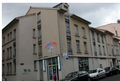
Elévation grande rue de la Guillotière Phot. Maryannick Chalabi IVR82_20046904610NUCA
