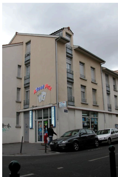
Elévation, angle de la grande rue de la Guillotière et de la rue Chalopin Phot. N. Giroud IVR82_20046904103NUCA
