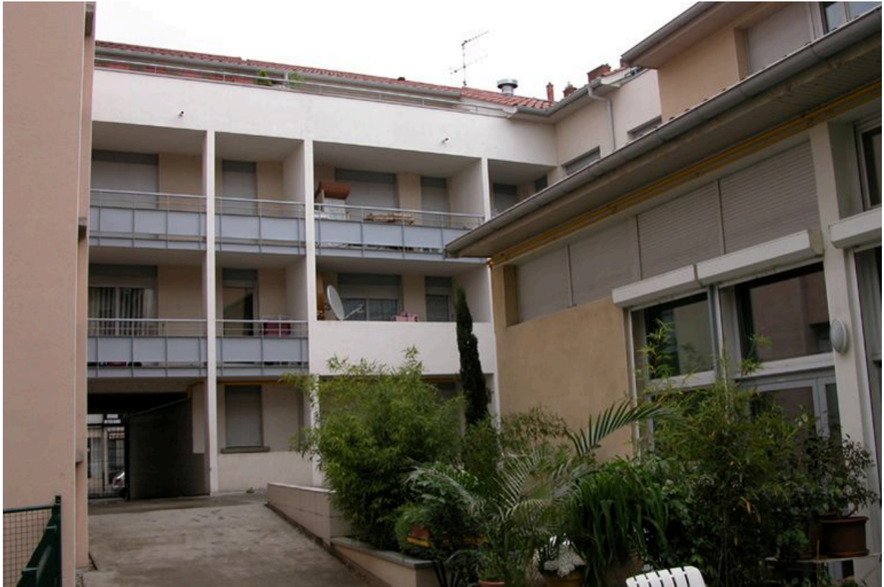
Elévation postérieure, grande rue de la Guillotière
