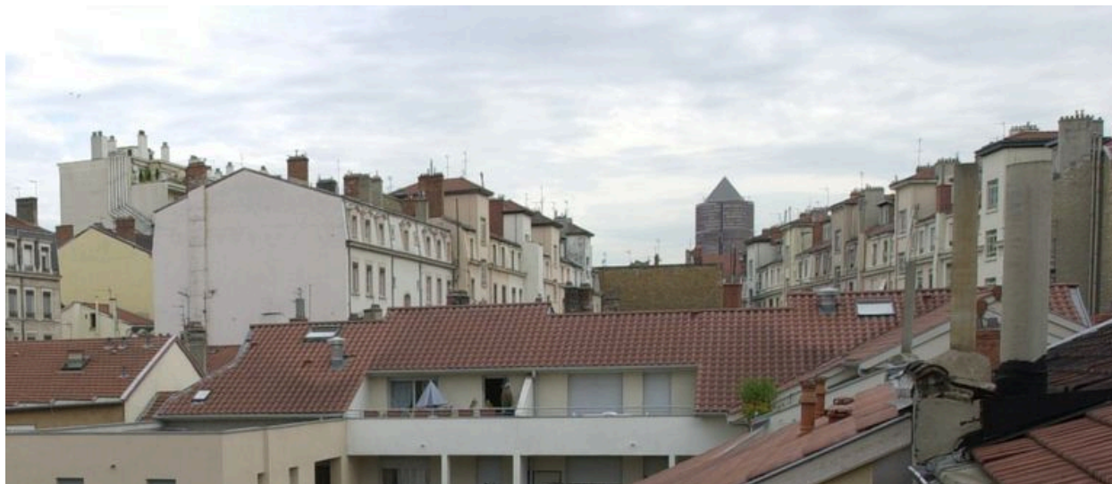
Elévation postérieure, grande rue de la Guillotière
