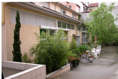
Jardin en coeur d'îlot, côté est Phot. Maryannick Chalabi IVR82_20046904105NUCA
