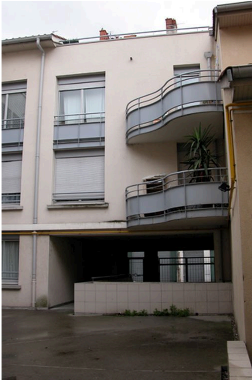
Elévation postérieure, rue Chalopin
