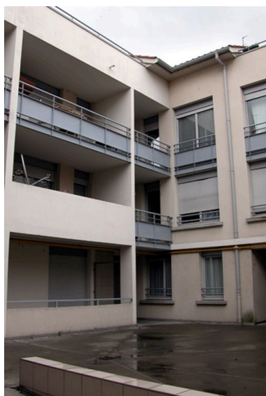
Elévations postérieures, angle grande rue de la Guillotière et rue Chalopin Phot. Maryannick Chalabi IVR82_20046904108NUCA
