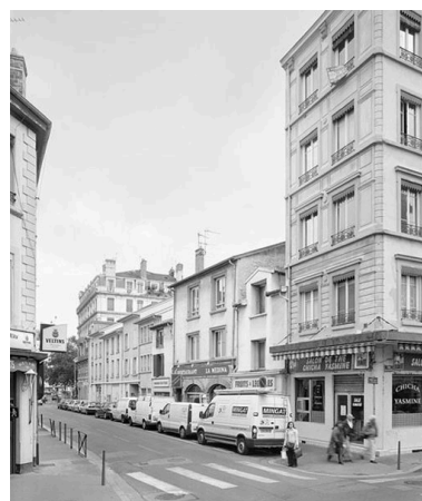
Vue générale depuis le nord-ouest Phot. Didier Gourbin IVR82_20066902154V
