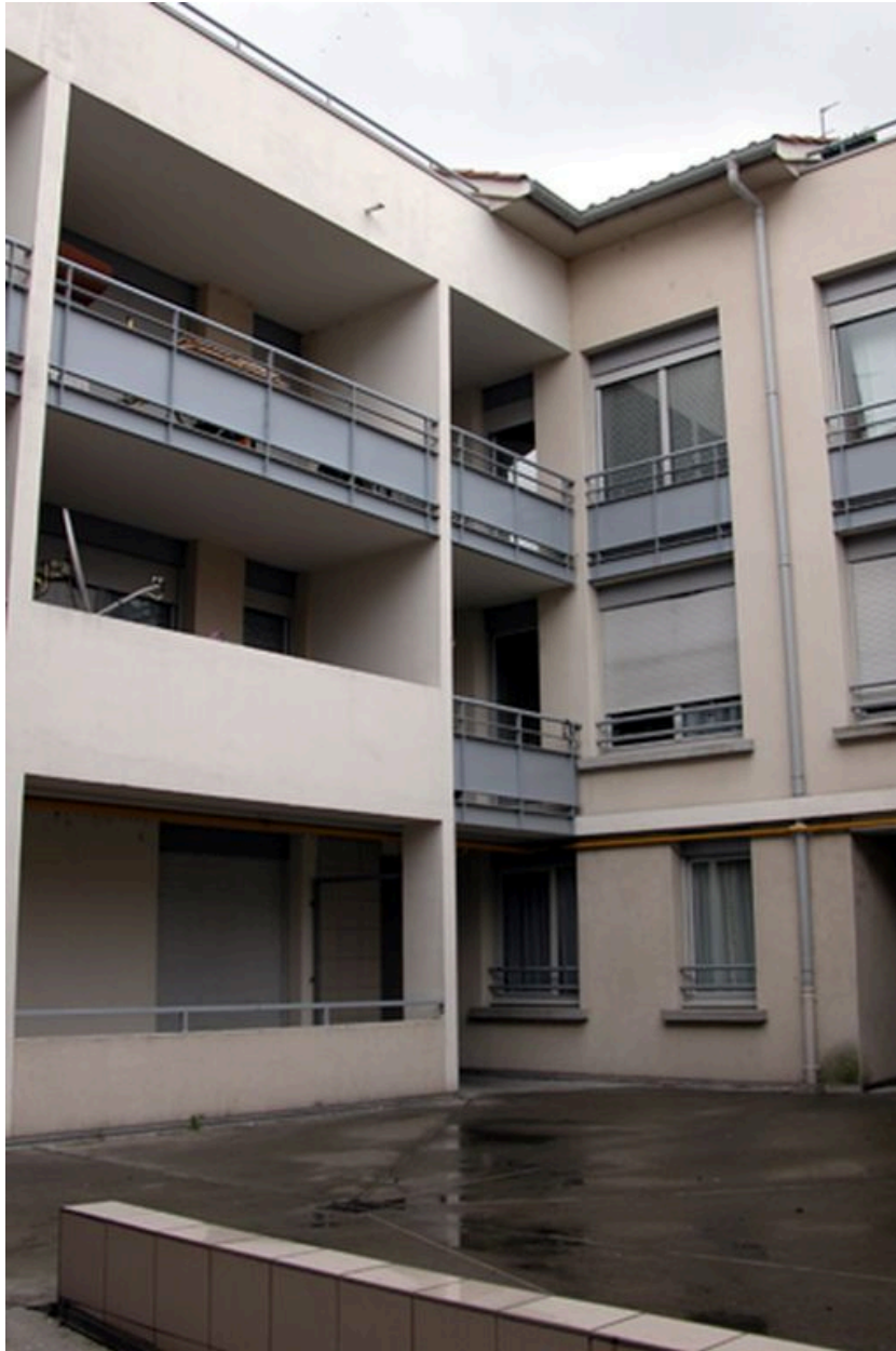
Elévations postérieures, angle grande rue de la Guillotière et rue Chalopin
