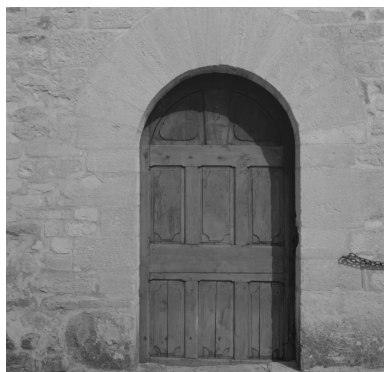
Vue d'ensemble. Phot. Alain Franchella IVR82_19992600010X
