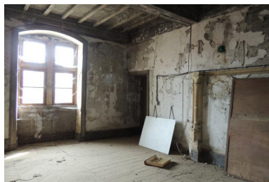
Étage noble, pièce n° 2, vue vers le sud. Phot. Elisabeth Dandel IVR84_20190100840NUCA
