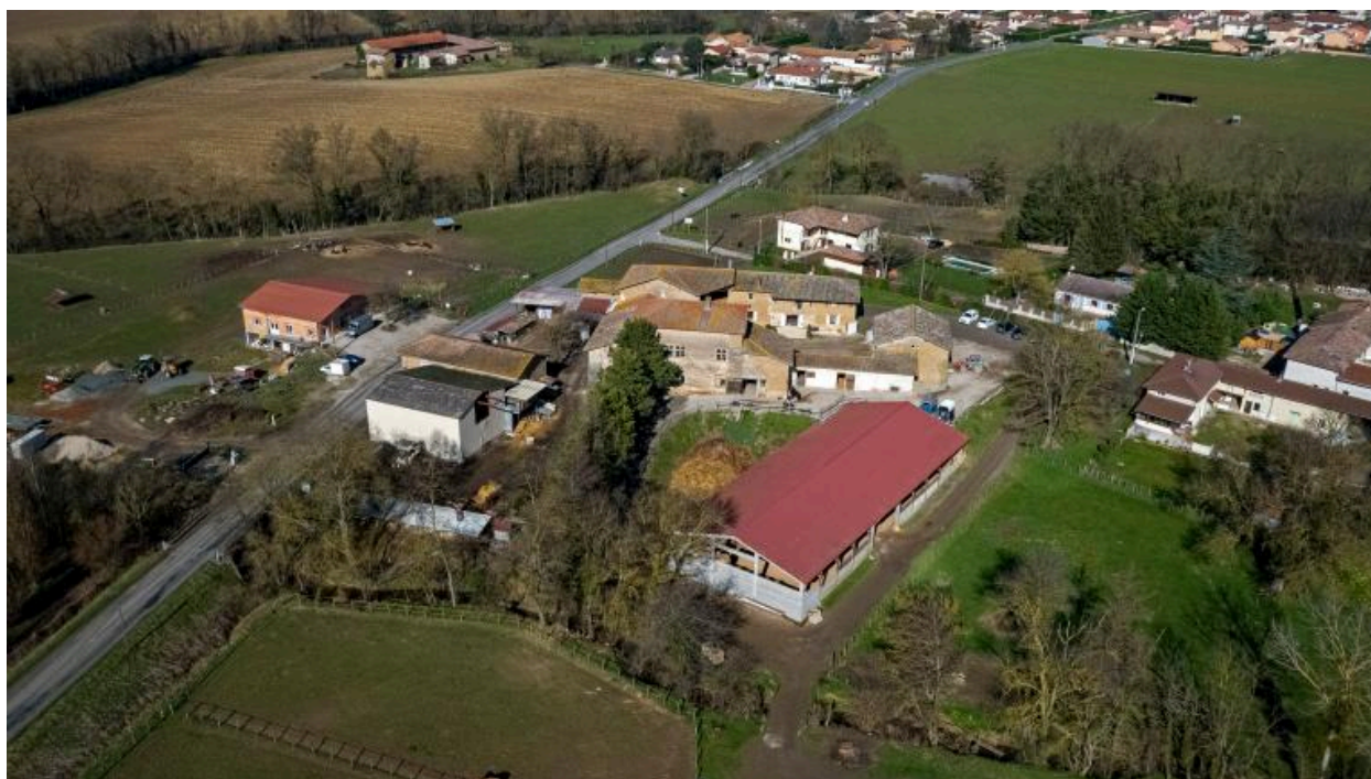
Vue aérienne, depuis le sud-est
