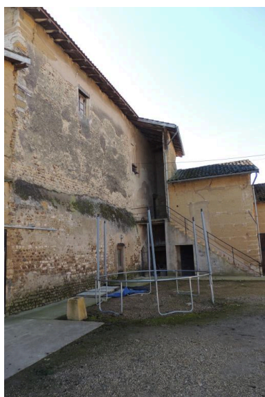
Le logis : façade sur cour et escalier d'accès. Phot. Elisabeth Dandel
