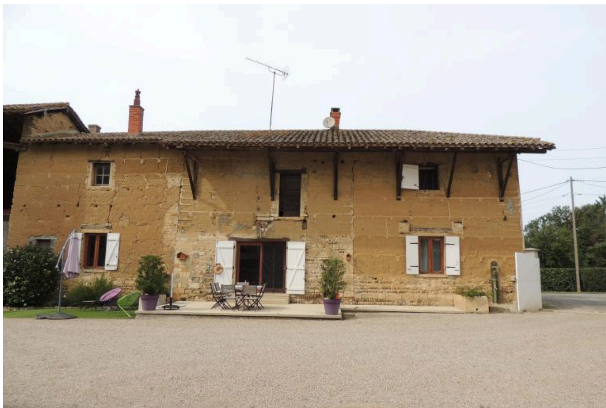
Bâtiment nord, façade sud.
