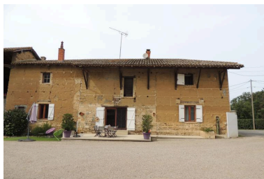
Bâtiment nord, façade sud. Phot. Elisabeth Dandel IVR84_20190100835NUCA
