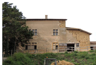
Le logis, façade sud. Phot. Elisabeth Dandel IVR84_20190100301NUCA
