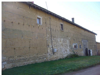
Bâtiment annexe, façade extérieure nord : chevet de la chapelle. Phot. Magali Delavenne IVR84_20190100308NUCA
