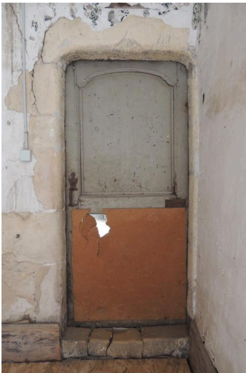
Porte de communication, linteau orné d'une accolade.
