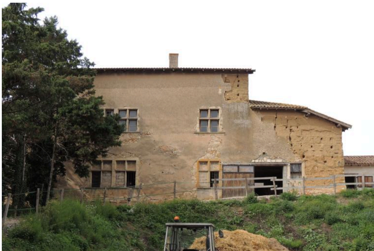
Le logis, façade sud.
