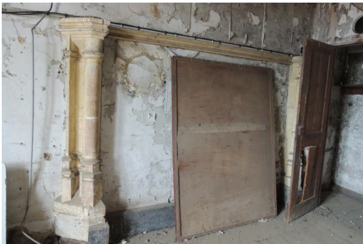
Étage noble, cheminée traversante, côté ouest.
