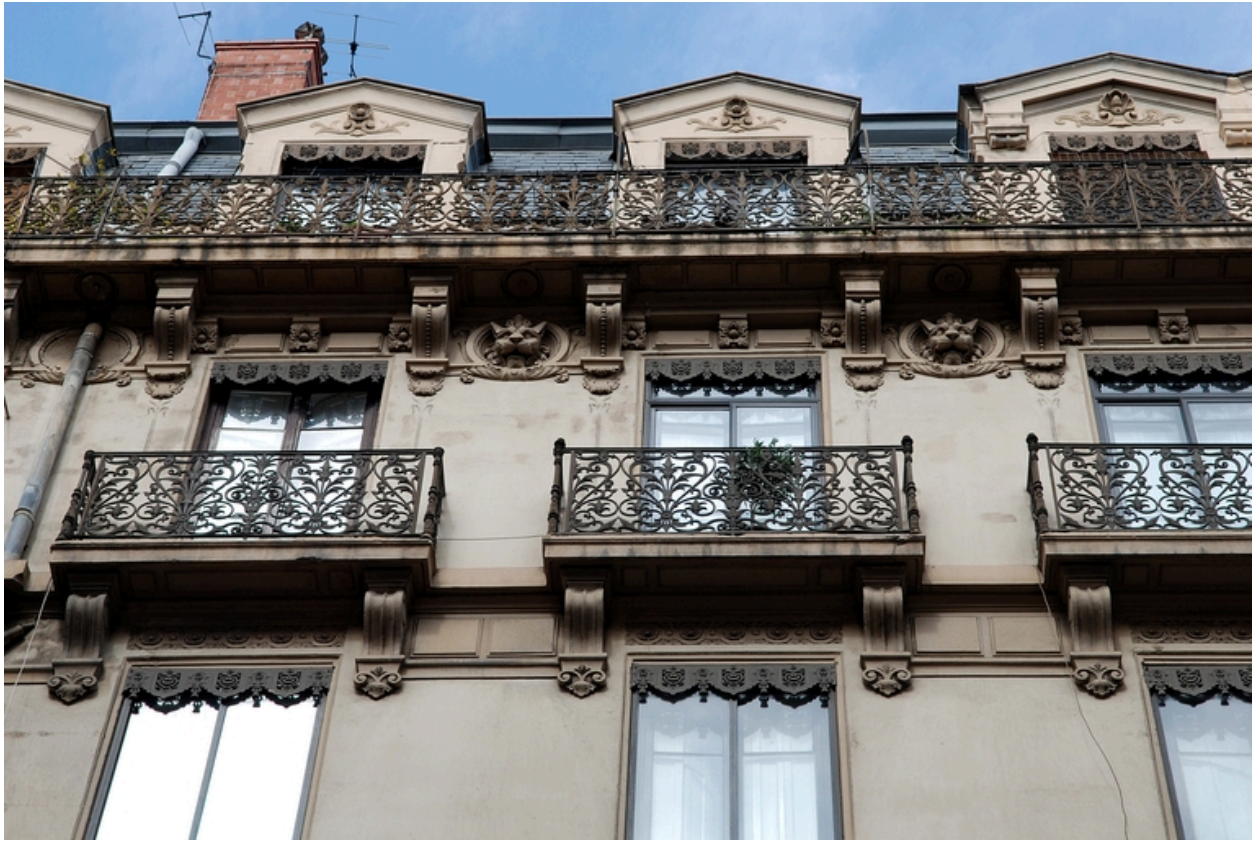
Elévation antérieure : ornementation des derniers étages
