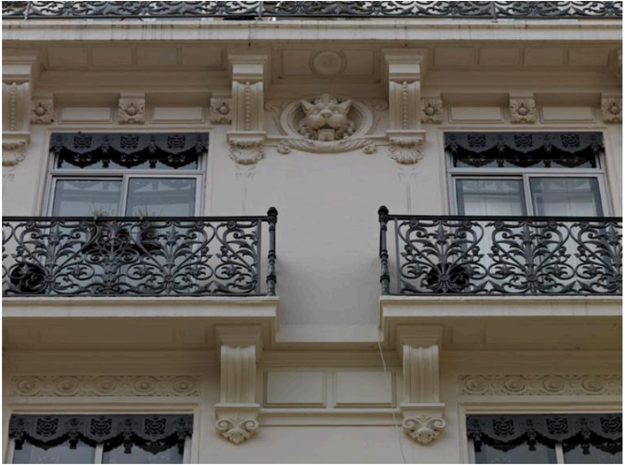
Elévation antérieure : ornementation des derniers étages, détail
