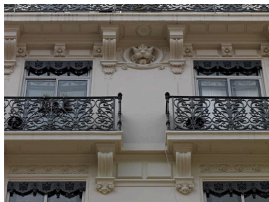
Elévation antérieure : ornementation des derniers étages, détail Phot. Eric Dessert IVR82_20126901499NUCA
