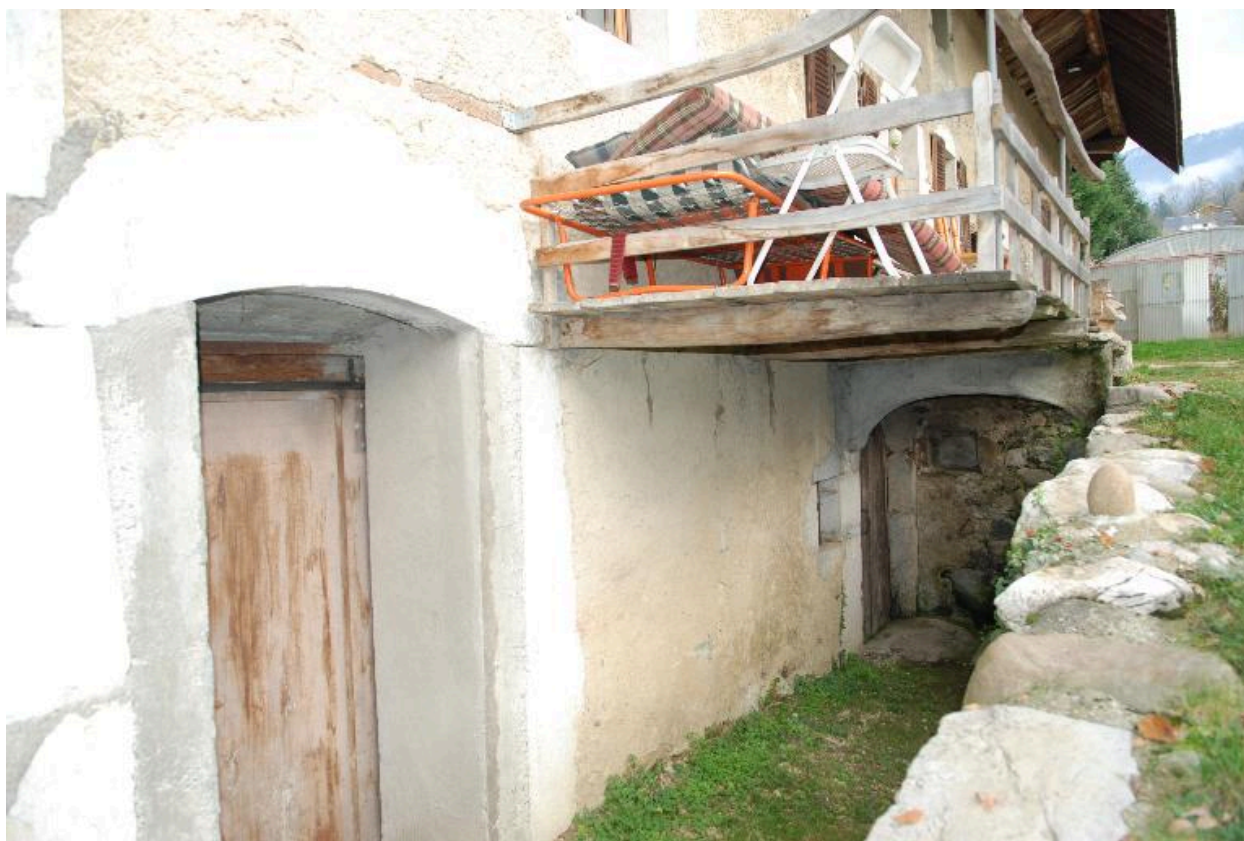
Vue d'ensemble de l'accès à la cave.
