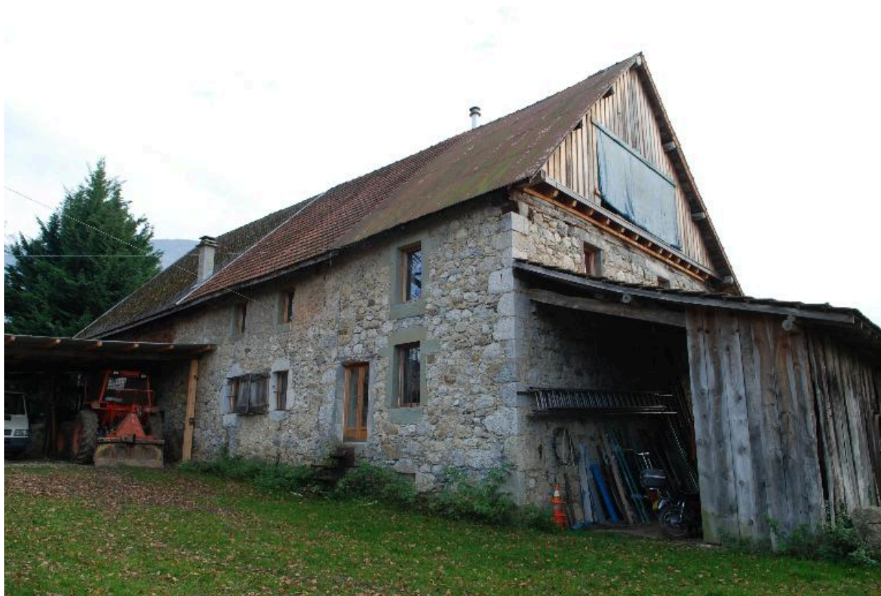
Vue d'ensemble de trois-quarts arrière droit.
