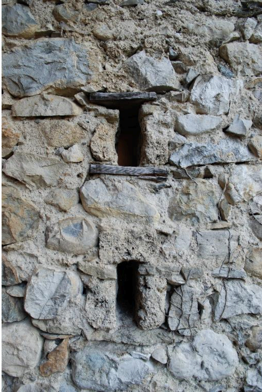
Détail des jours du placard réfrigéré, façade arrière de la ferme.
