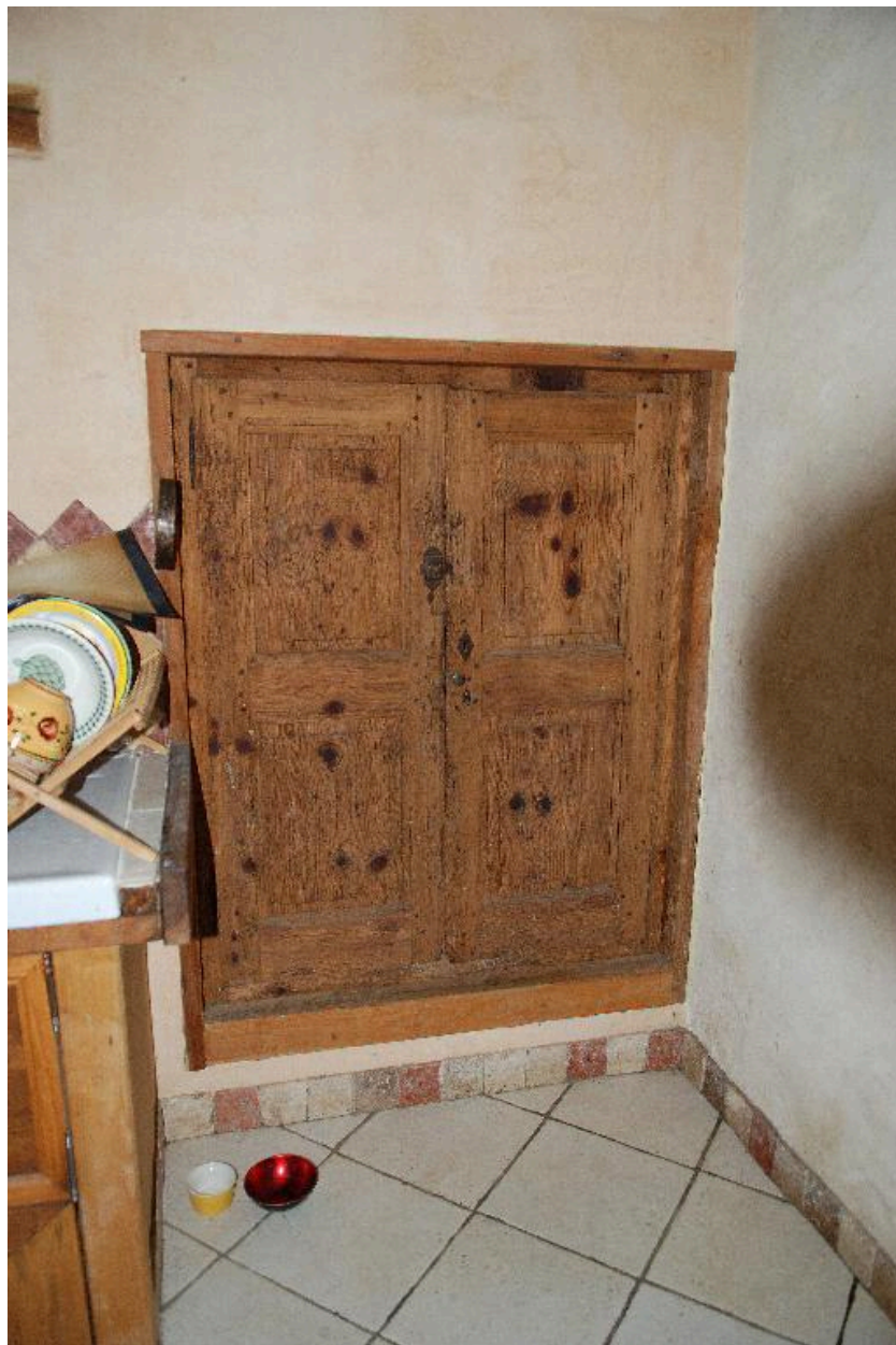
Vue d'ensemble du placard réfrigéré, portes closes.
