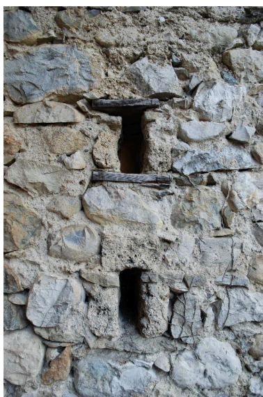
Détail des jours du placard réfrigéré, façade arrière de la ferme. Phot. Thierry Monnet IVR84_20177301950NUCA
