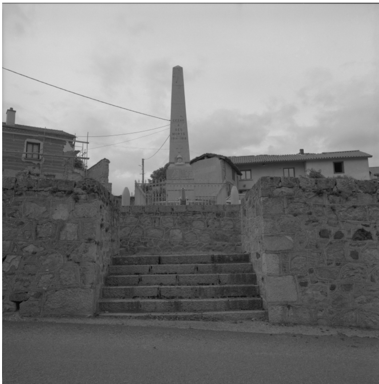
Vue d'ensemble de face.
