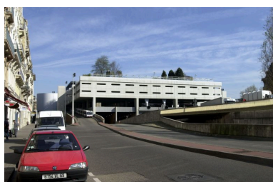
Vue d'ensemble du centre d'échange depuis les quais de la Saône Phot. Françoise Vitali IVR82_20016901055NUCA
