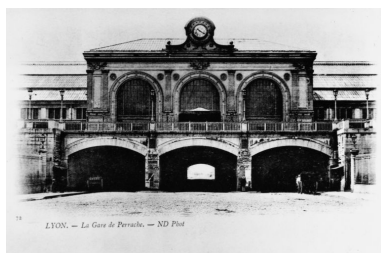
La gare de Perrache et ses voûtes. Carte postale, 1er quart 20e siècle IVR82_20026900107NUCB
