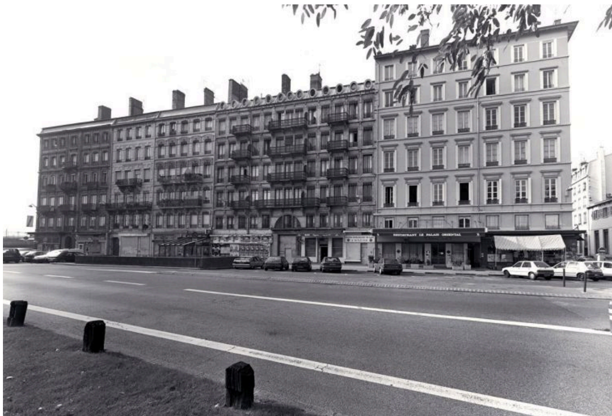
Vue d'ensemble des immeubles, 30-40 cours de Verdun-Perrache
