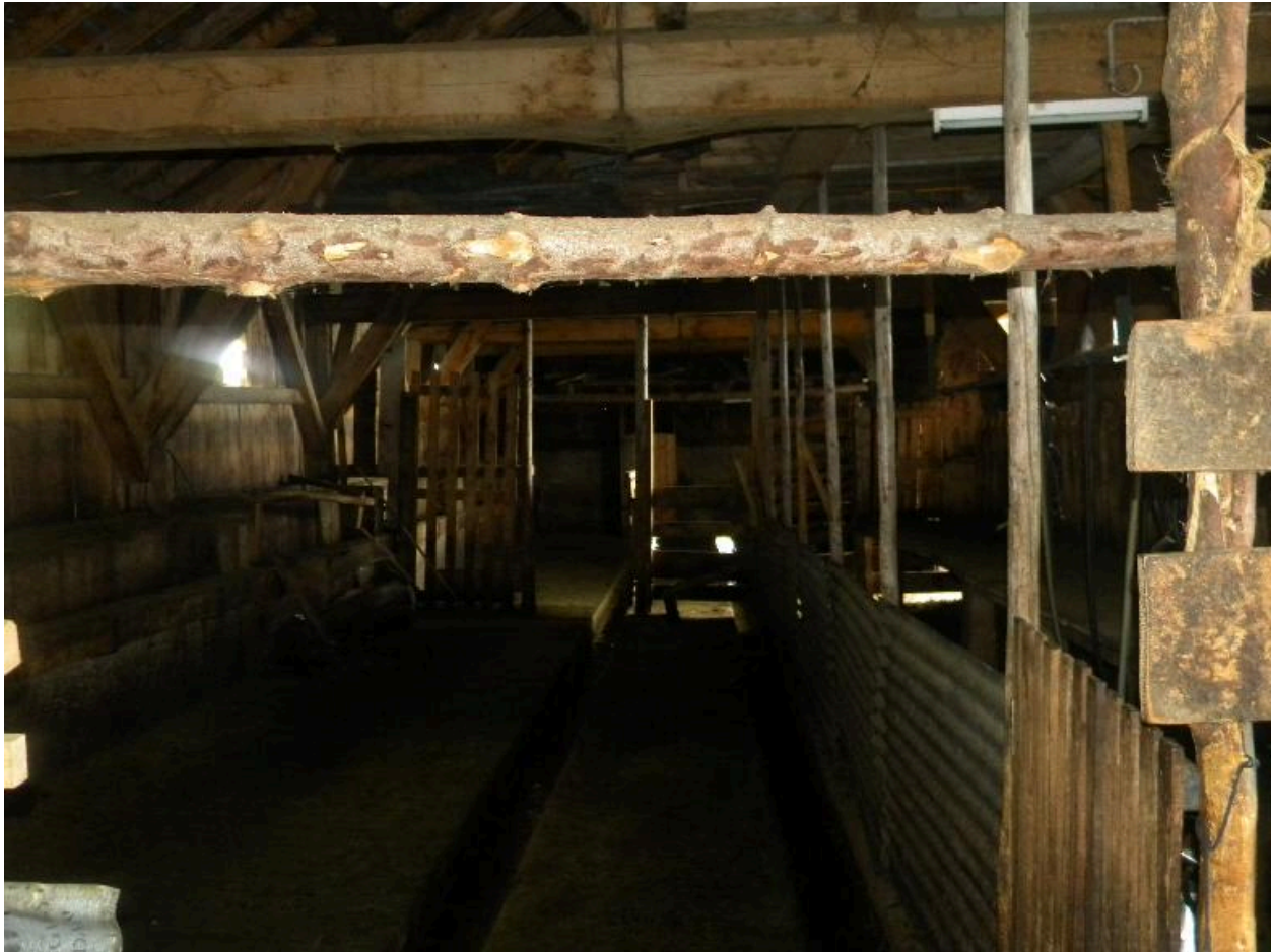
Vue de l'intérieur de l'étable.
