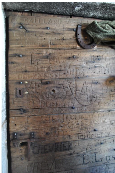
Vue de la porte du bâtiment d'habitation avec ses inscriptions.
