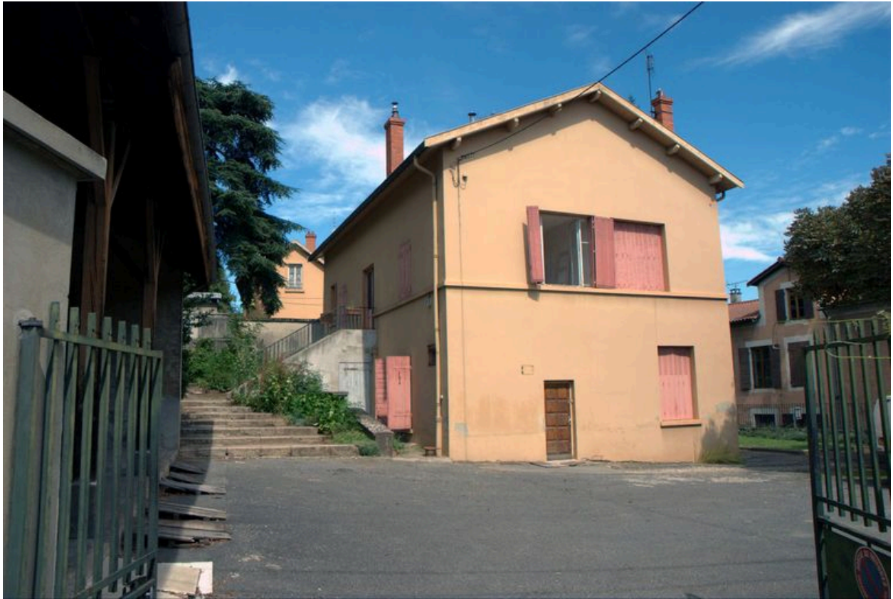
Vue de l'élévation sud
