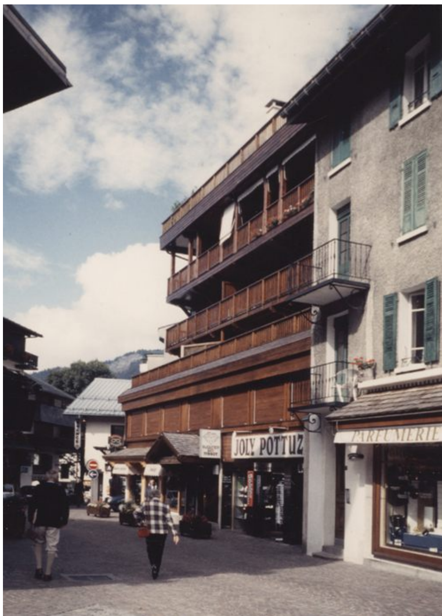
Façade principale. Etat en 1995
