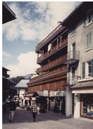
Façade principale. Etat en 1995 Phot. F. Véry IVR82_20127402098NUCA
