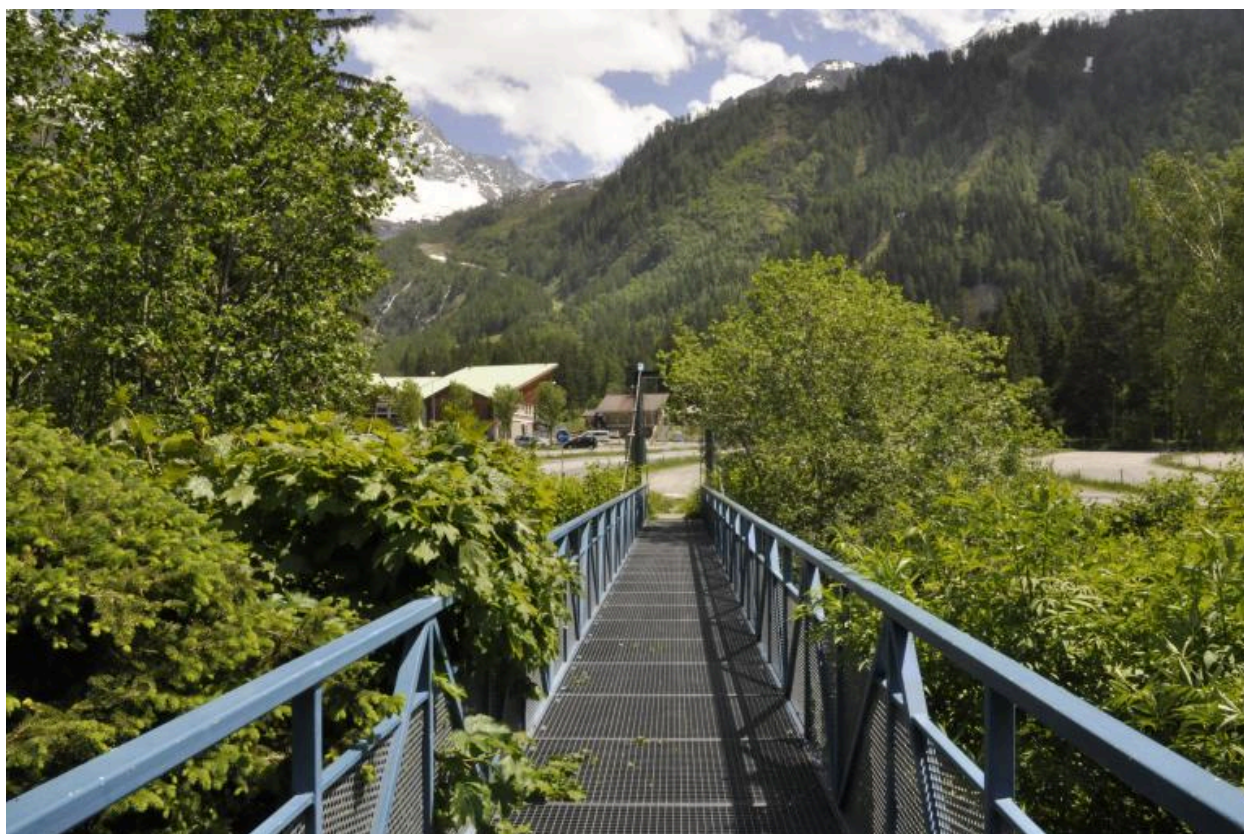
Détail du tablier de la passerelle
