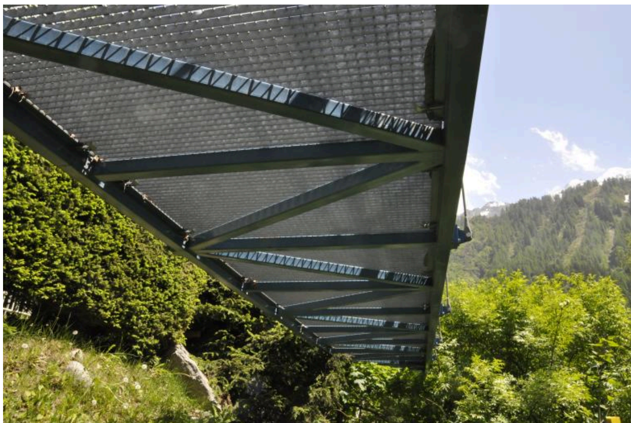
Dessous de tablier composé d'une ossature métallique
