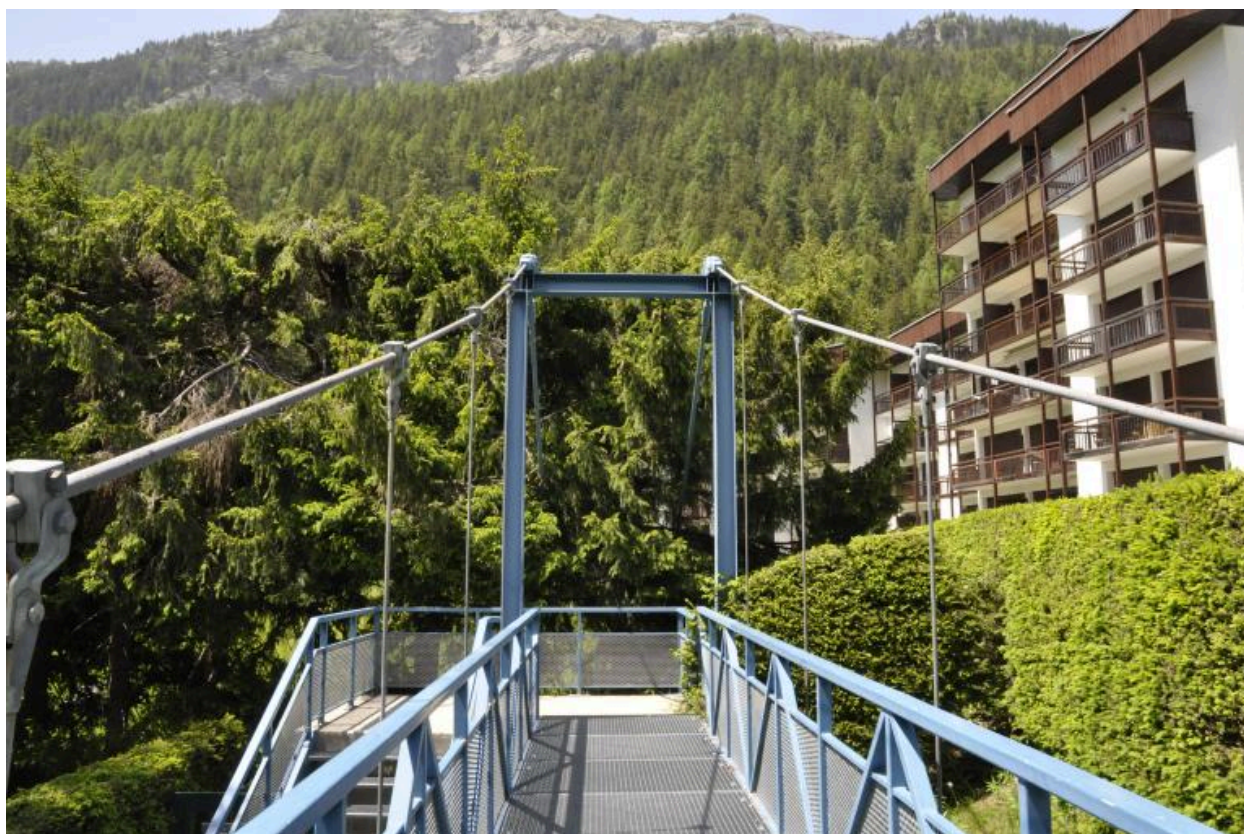
Vue du pylône situé en rive droite du torrent de l'Arve
