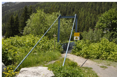
Vue du pylône situé sur la rive gauche stabilisé par des tyrans métalliques Phot. Samir Mahfoudi IVR84_20207401145NUCA
