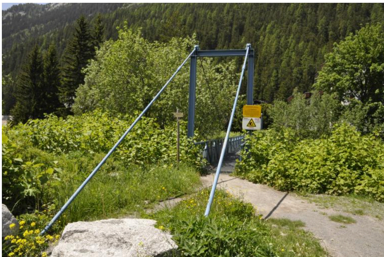
Vue du pylône situé sur la rive gauche stabilisé par des tyrans métalliques
