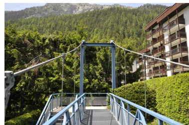
Vue du pylône situé en rive droite du torrent de l'Arve Phot. Samir Mahfoudi IVR84_20207401147NUCA
