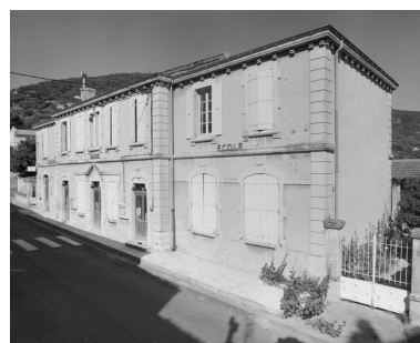
Vue d'ensemble du bâtiment depuis le sud-ouest. Phot. Alain Franchella IVR82_19982600440X
