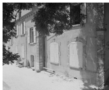
Élévation postérieure sur cour, vue partielle. Phot. Alain Franchella IVR82_19982600444X
