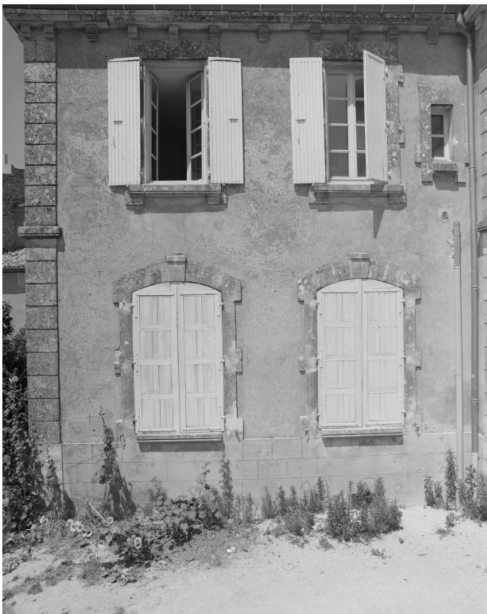
Elévation sur cour, partie centrale.
