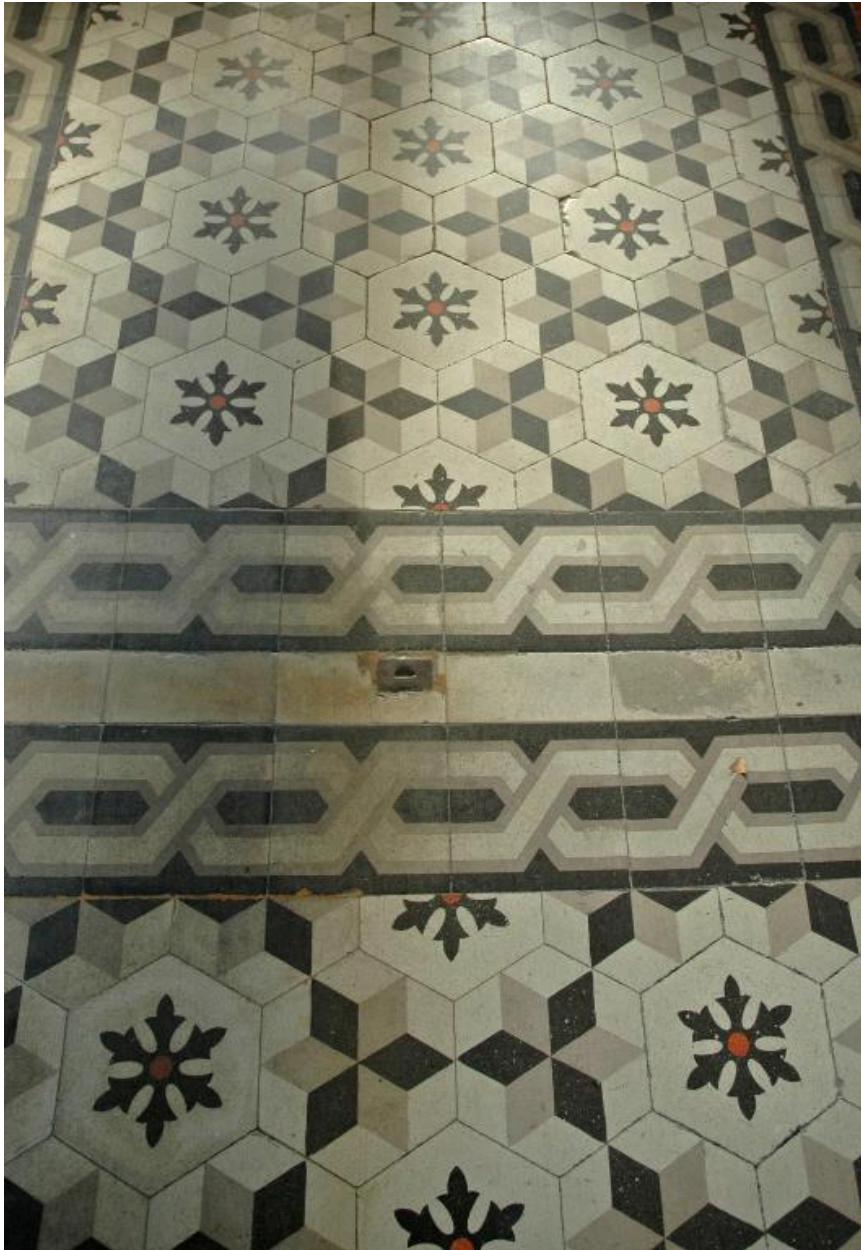
Vue intérieure du bâtiment sur quai : détail du pavement
