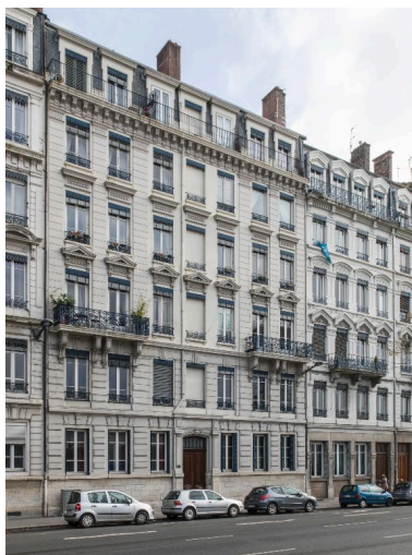
Vue d'ensemble de l'élévation sur quai Phot. Martial Couderette IVR82_20156901609NUCA
