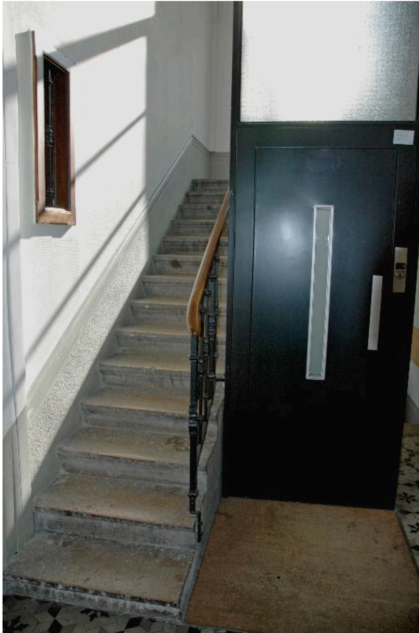
Vue intérieure du bâtiment sur quai : l'escalier
