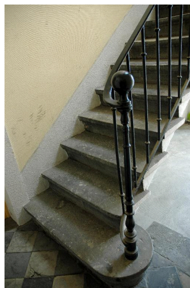
Vue intérieure du bâtiment sur cour : le départ de l'escalier Phot. Magali Delavenne IVR82_20146902815NUCA
