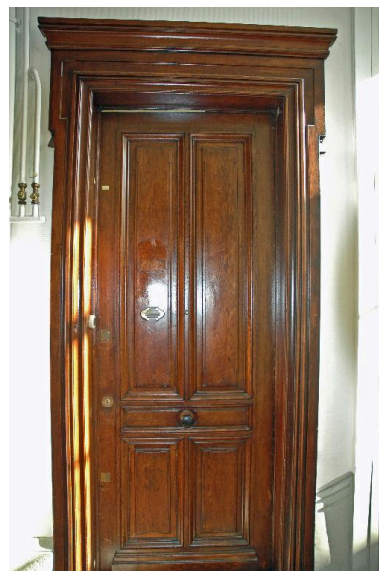
Vue intérieure du bâtiment sur quai : une porte palière Phot. Magali Delavenne IVR82_20146902810NUCA
