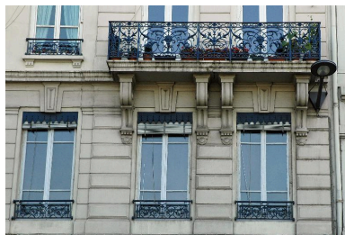
Elévation sur quai, détail des premier et deuxième niveaux Phot. Magali Delavenne IVR82_20146902806NUCA
