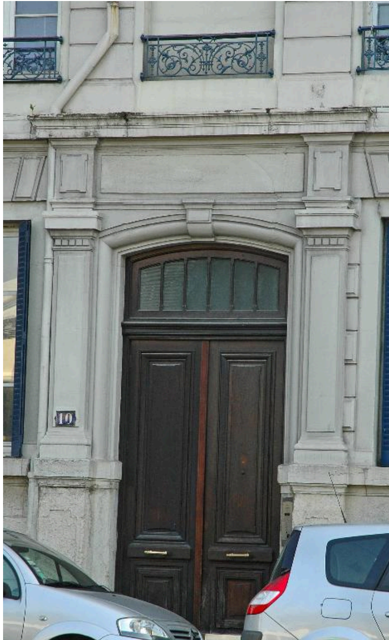
Elévation sur quai, détail de la porte d'entrée
