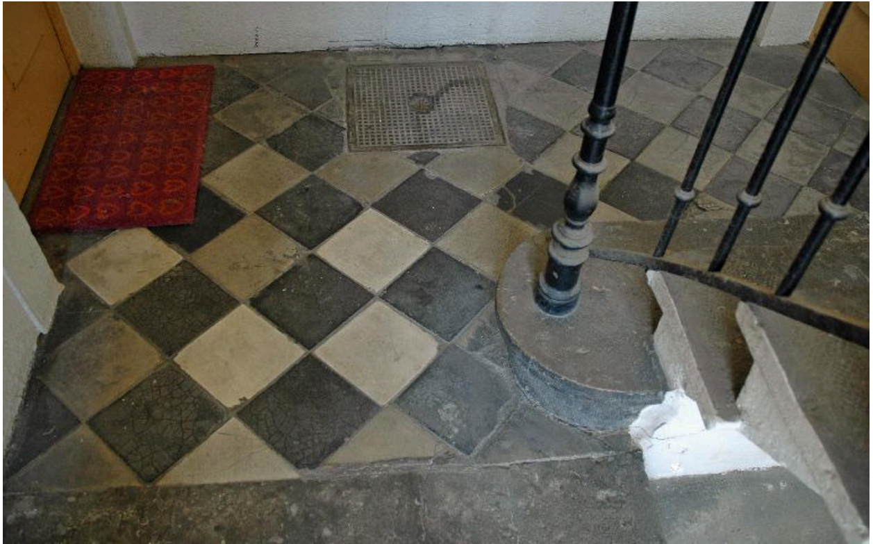
Vue intérieure du bâtiment sur cour : le pavement au rez-de-chaussée
