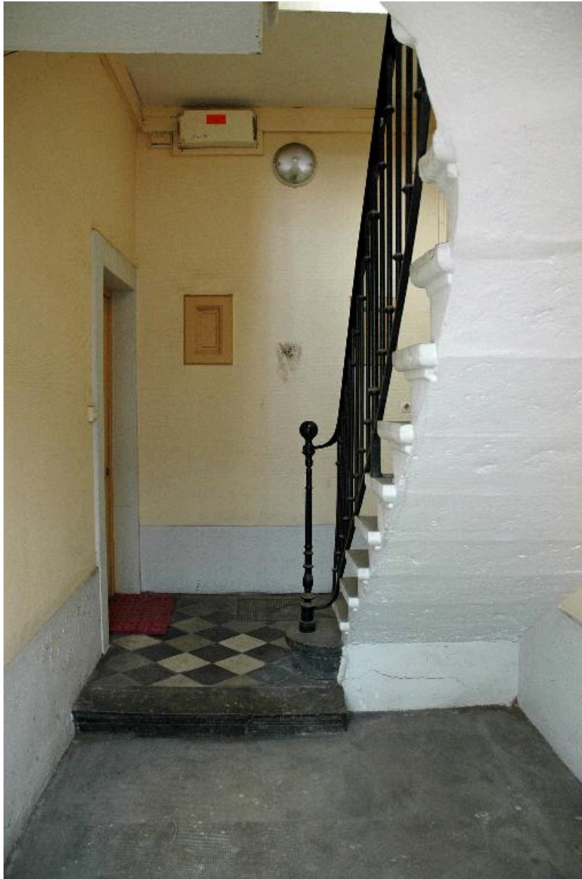
Vue intérieure du bâtiment sur cour : l'escalier
