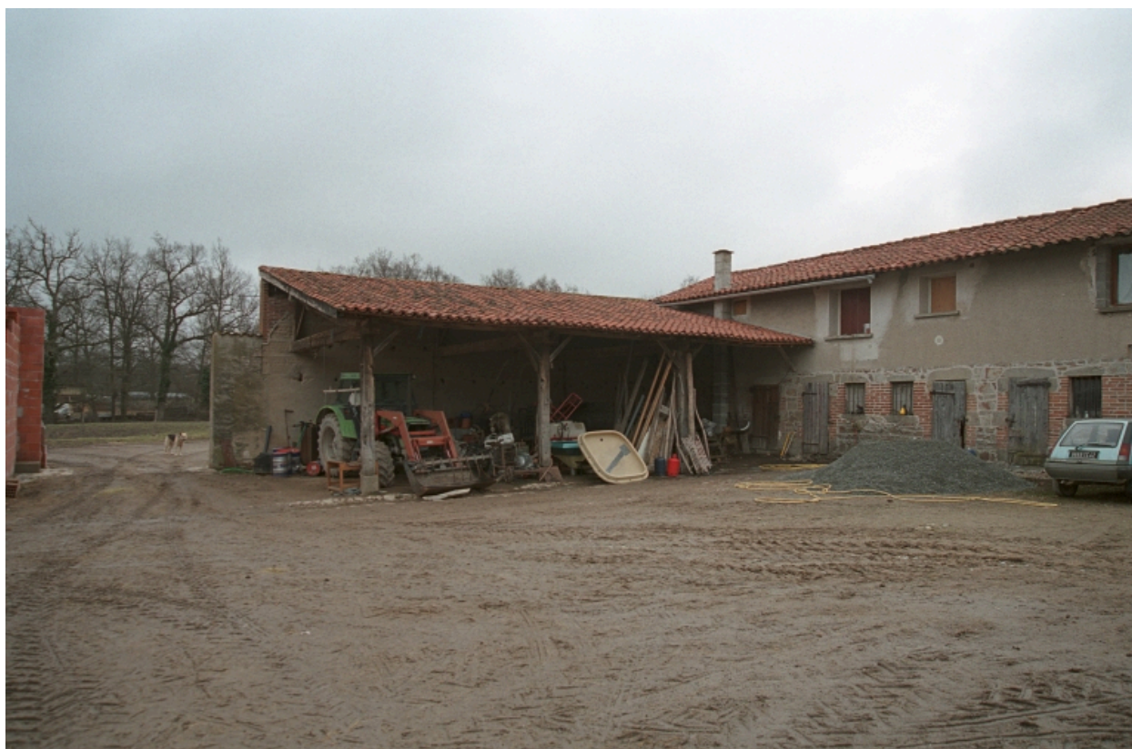
Vue d'ensemble du corps de bâtiment est, remise.
