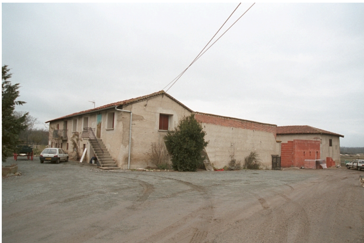
Vue générale de la ferme à cour fermée.
