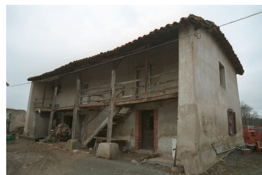
Vue d'ensemble du logis de trois quarts. Phot. Thierry Monnet IVR82_20054200145ZE
