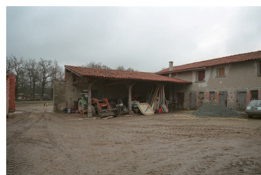
Vue d'ensemble du corps de bâtiment est, remise. Phot. Thierry Monnet IVR82_20054200148ZE
