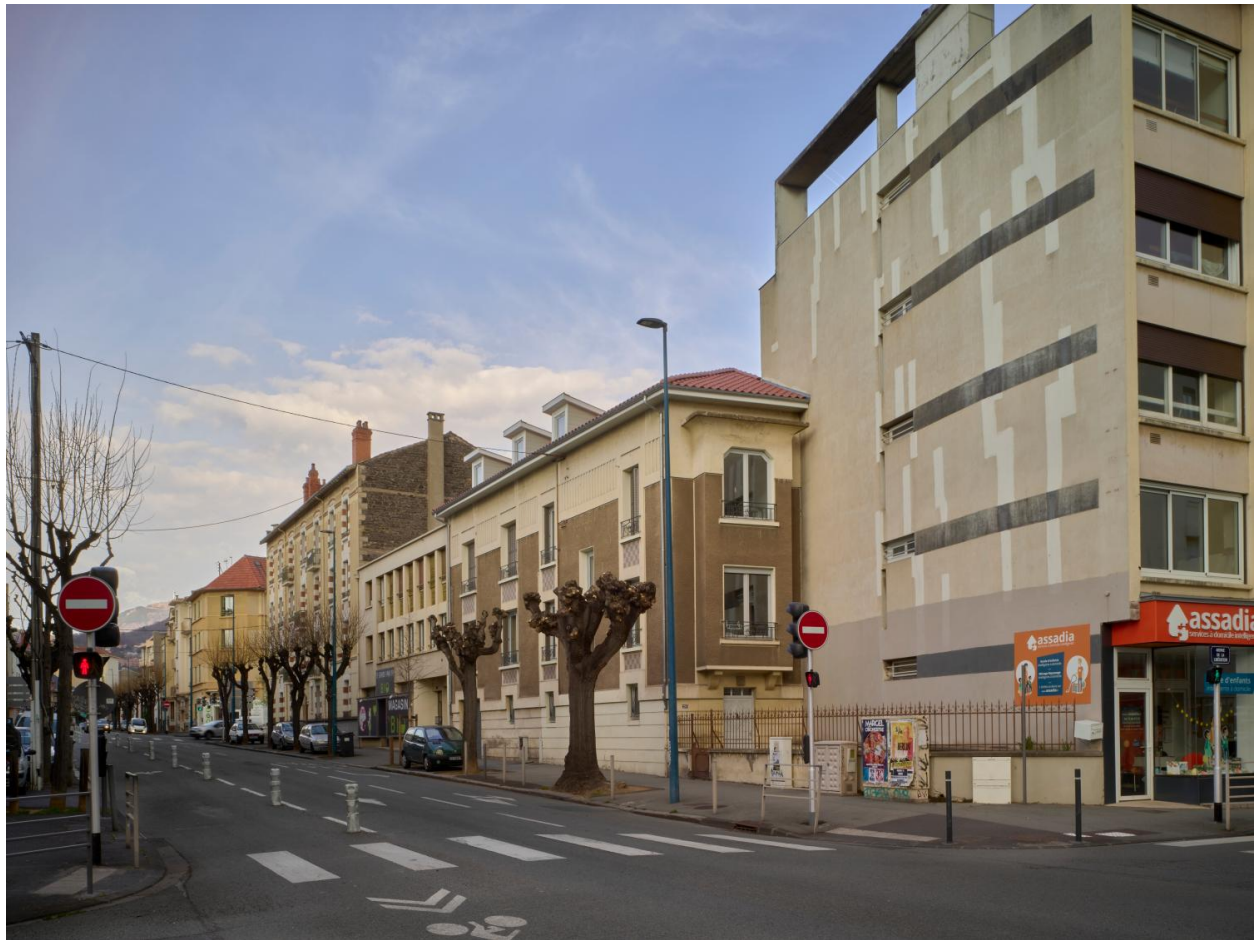
Elévation aveugle et immeuble en fer à repasser
