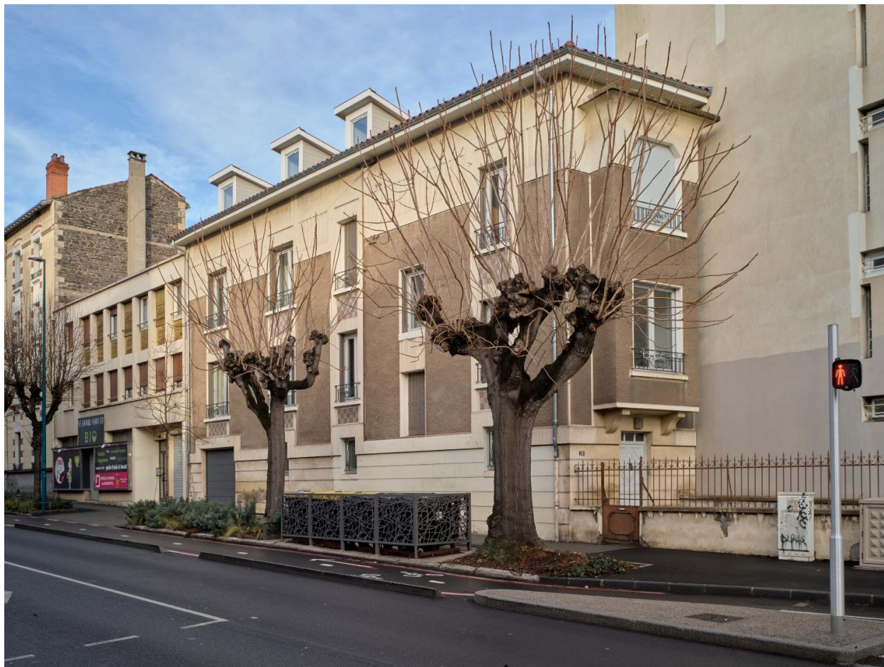
Façade sur le boulevard Jean-Jaurès et travée d'entrée en angle. Immeuble en fer à repasser.
