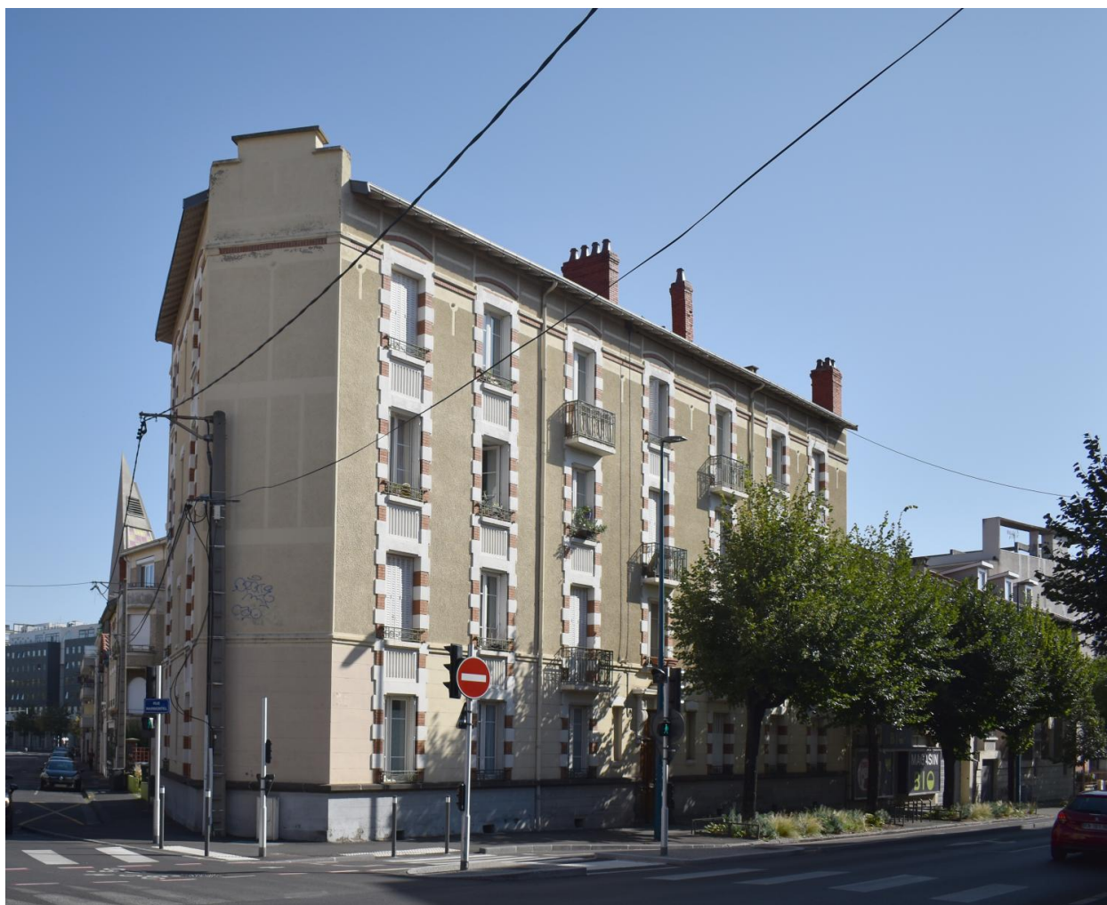
Façade sur le boulevard Jean-Jaurès, angle sur la rue Marmontel, n°34 bd Jean-Jaurès
