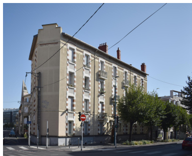
Façade sur le boulevard Jean-Jaurès, angle sur la rue Marmontel, n°34 bd Jean-Jaurès Phot. Félicie Fougère IVR84_20256301335NUCA
