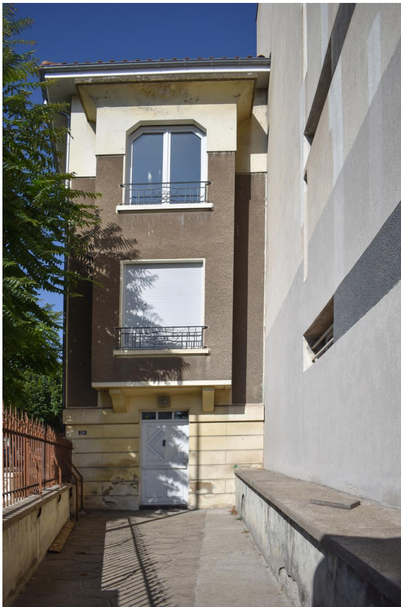
Travée d'entrée latérale et mur aveugle
