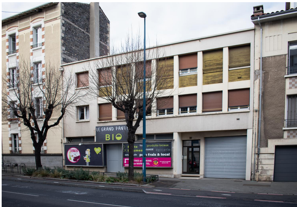
Façade sur le boulevard Jean-Jaurès, n°30 bd Jean-Jaurès
