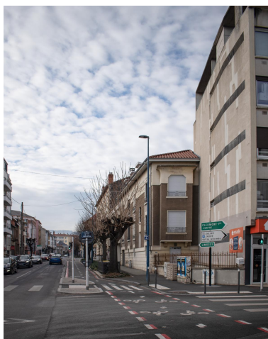
Mur aveugle et travée d'entrée latérale au boulevard Jean-Jaurès Phot. Félicie Fougère IVR84_20256300244NUCA
