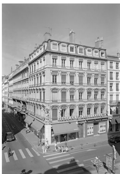
Vue générale Phot. Eric Dessert IVR82_20056901735P
