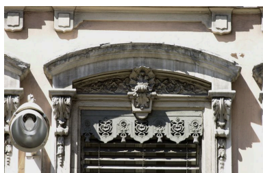
Façade principale, 2e niveau, détail du couronnement de la 2e fenêtre Phot. Bernard Ducouret IVR82_20046900901NUCA
