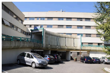
Rampe d'accès aux urgences, vue d'ensemble Phot. Denys Harreau
