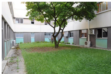
Cour intérieure Phot. Denys Harreau IVR82_20147300782NUCA
