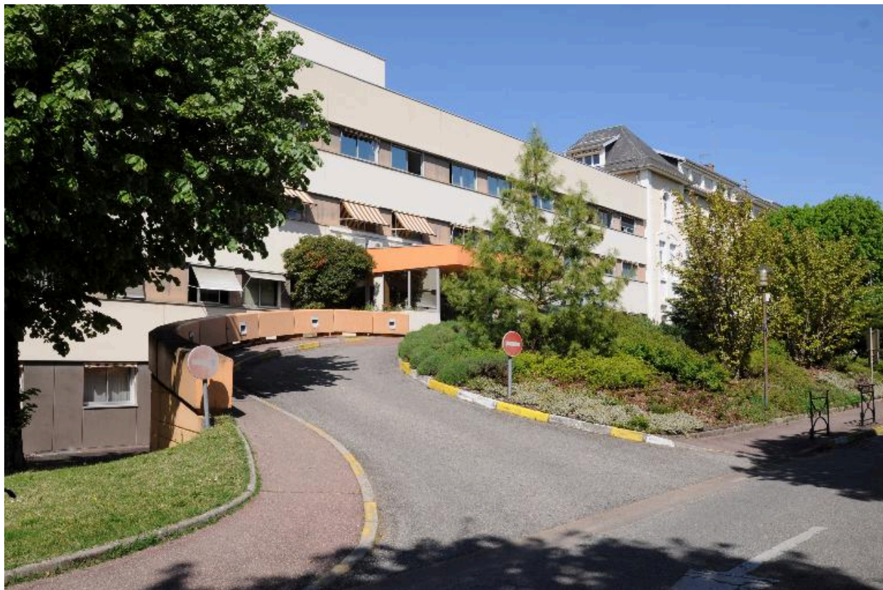
Vue depuis l'ouest, rampe d'accès à l'entrée principale
