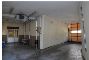
Intérieur du tunnel d'accès aux urgences Phot. Denys Harreau IVR82_20147300523NUCA
