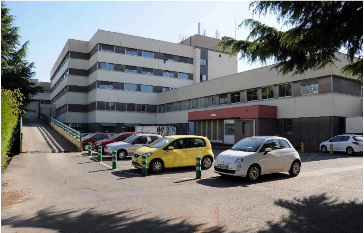
Vue depuis l'arrière
