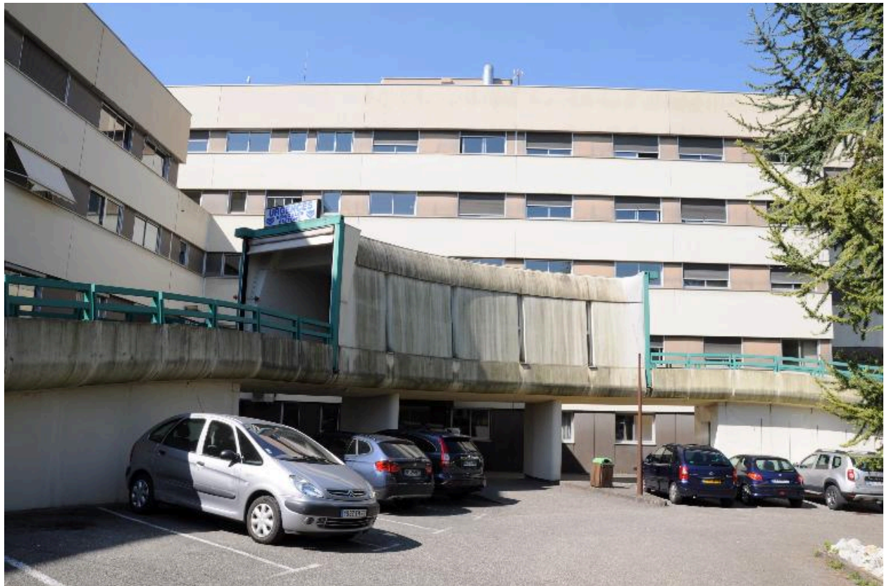
Rampe d'accès aux urgences, vue d'ensemble
