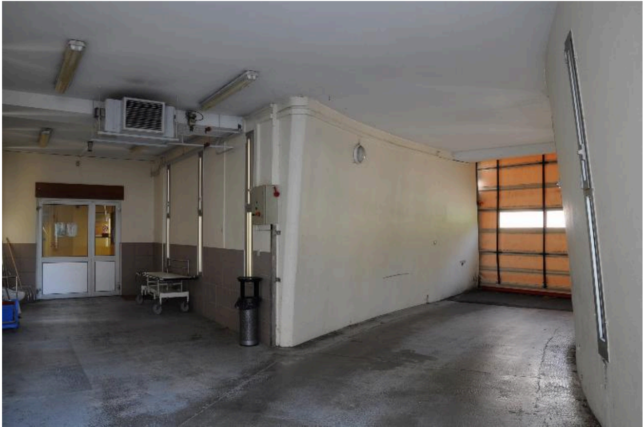
Intérieur du tunnel d'accès aux urgences
