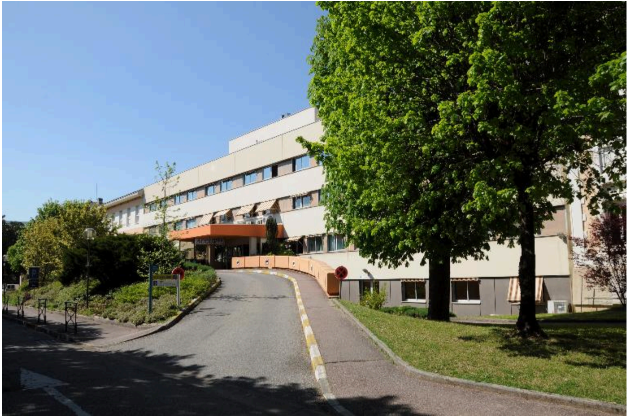
Vue depuis l'est, rampe d'accès à l'entrée principale
