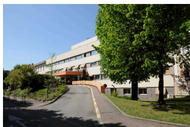
Vue depuis l'est, rampe d'accès à l'entrée principale Phot. Denys Harreau
