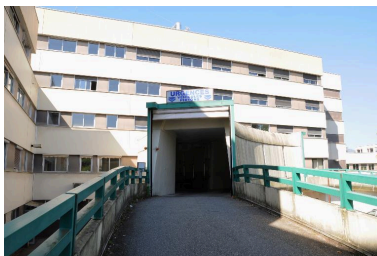
Rampe et tunnel d'accès aux urgences Phot. Denys Harreau
