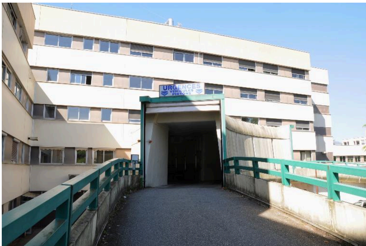
Rampe et tunnel d'accès aux urgences
